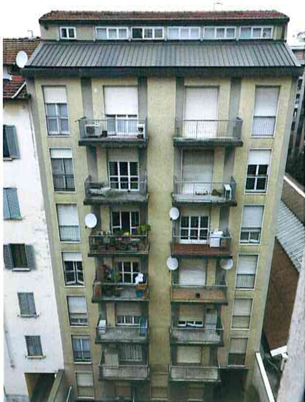
Viste al fabbricato interno
