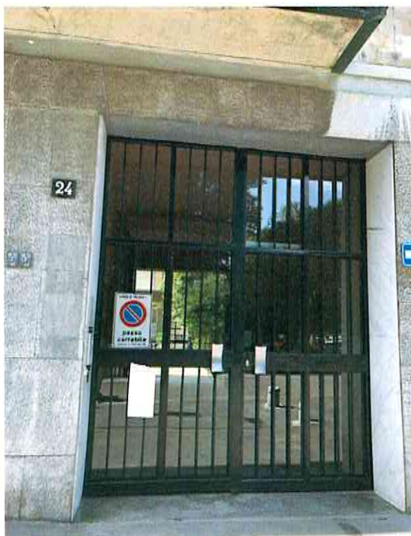
Vista portone di ingresso civico N.24
