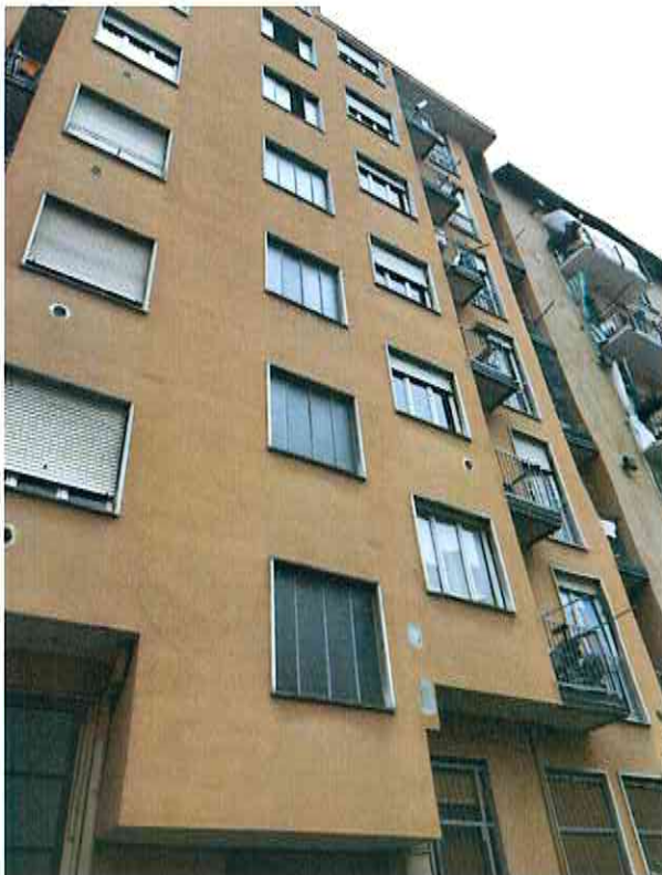
Viste al fabbricato interno dal retro
