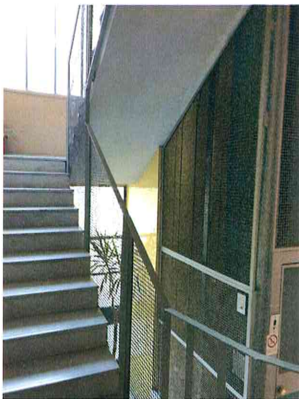
Vista vano scala comune
