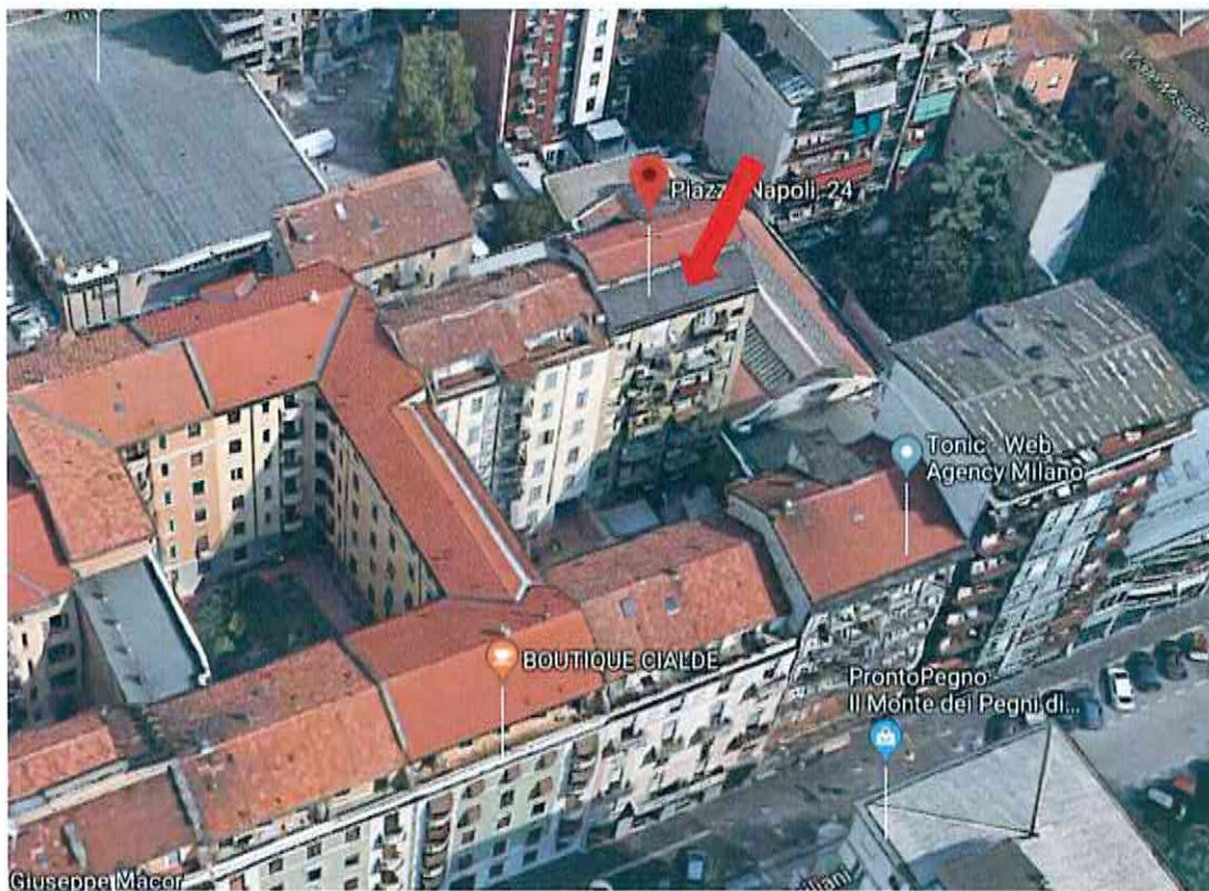
Vista assonometrica del fabbricato da Google Maps
