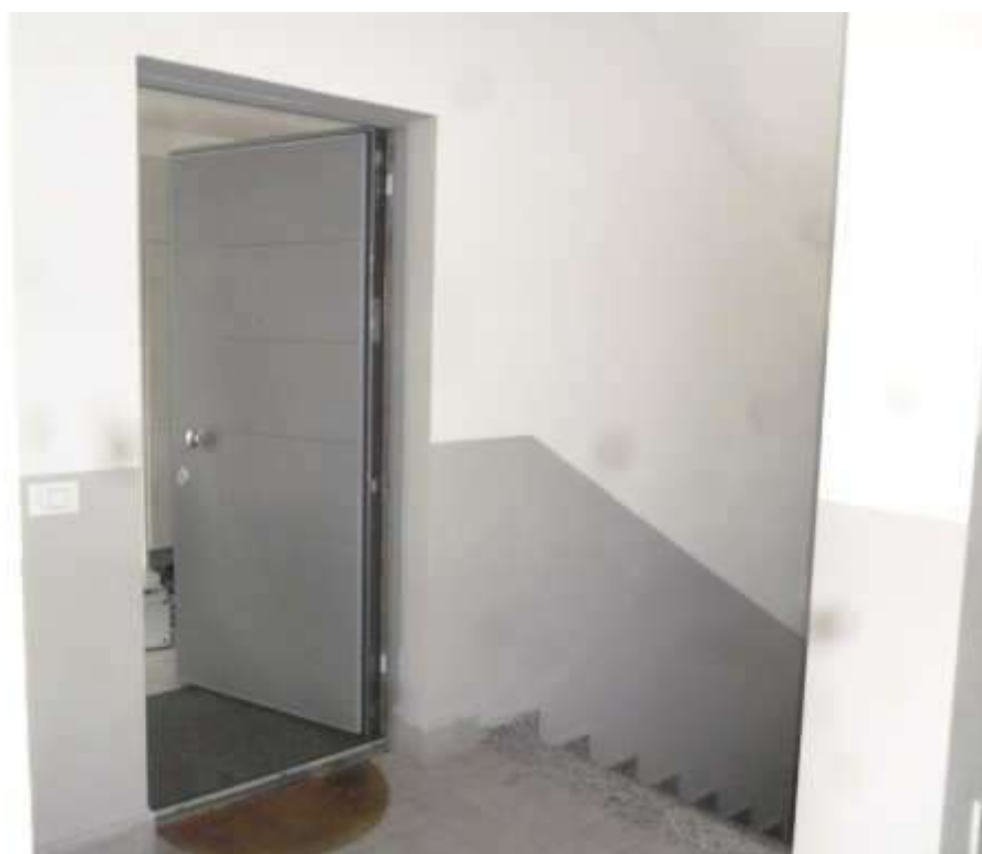
FOTO 4 - Ingresso all'abitazione Sub. 8
