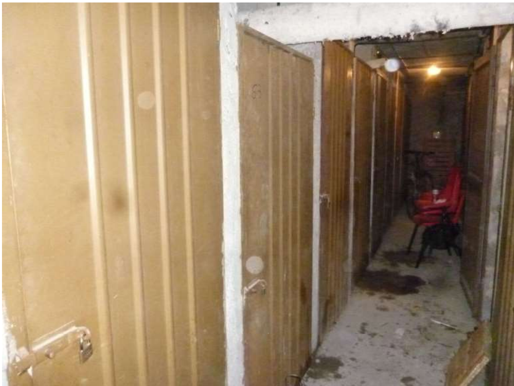
FOTO 18 – Corridoio comune piano cantinato
