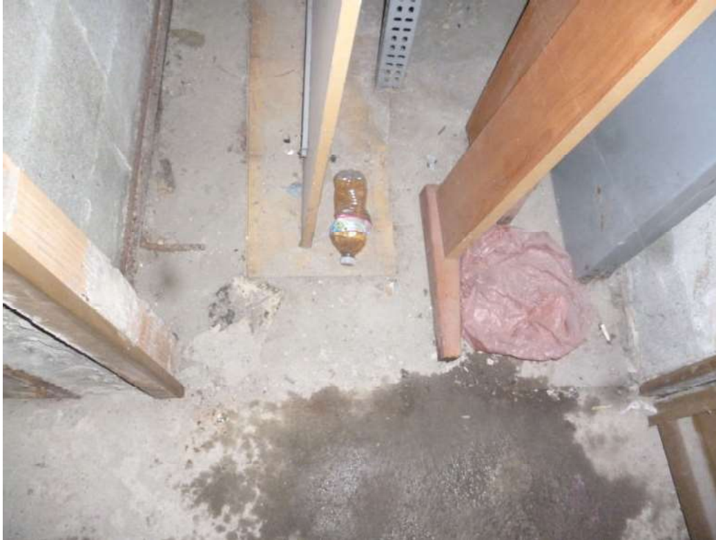
FOTO 17 – Particolare pavimentazione vano cantina
