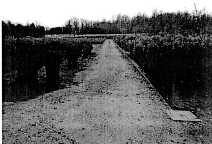
Fig. 2 strada di servizio in terra battuta con pozzetto per impianto irrigazione
