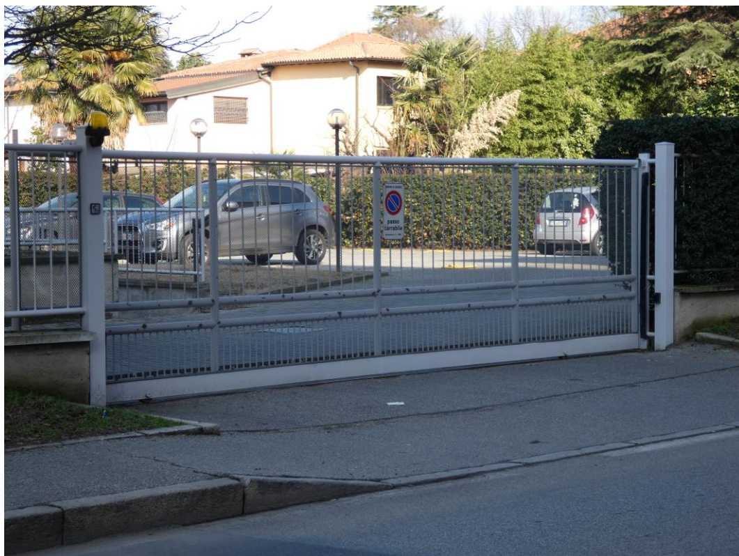
Foto 2: Accesso carraio da Via Sibilla Aleramo
