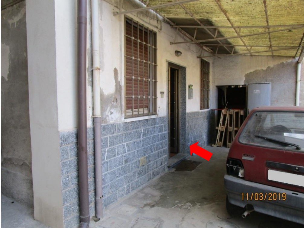
Foto 3 – Porta di accesso all'appartamento sub 719
