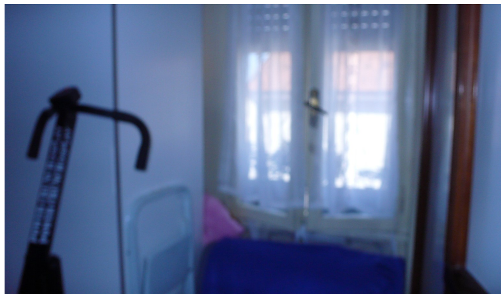
Vista 12 - serramento CAMERA
