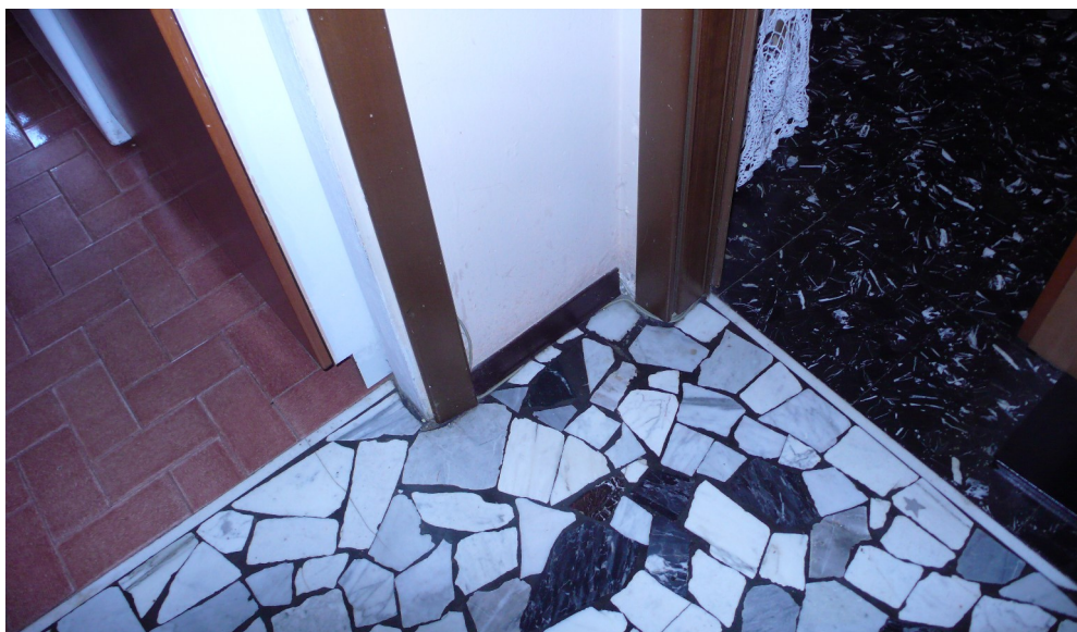
Vista 15 - part. PAVIMENTI
