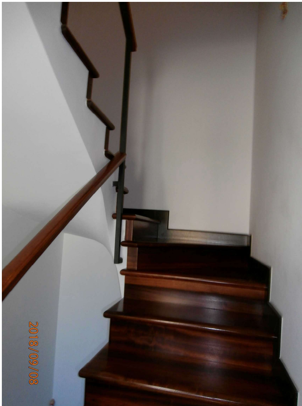
Foto n.15. – Scorcio della rampa della scala che conduce al secondo piano, dove è ubicata la zona notte.
