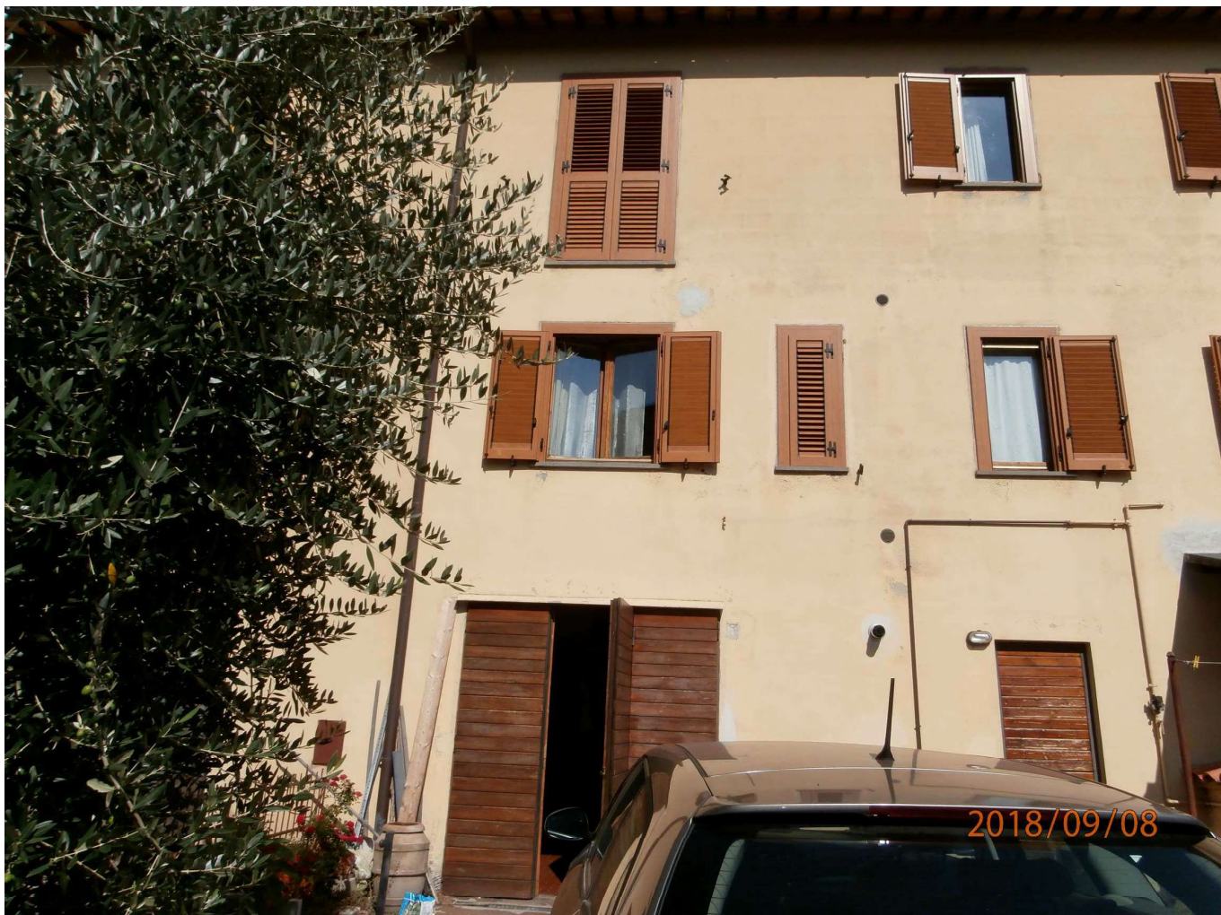
Foto n.22. – Primo piano della porzione di facciata posteriore di pertinenza dell'unità immobiliare staggita.
