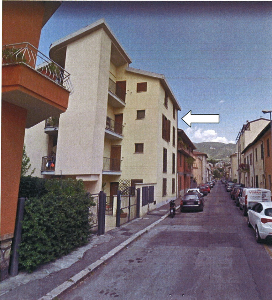
Vista dell'edificio da via Emilia
