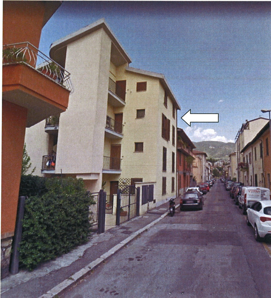
Vista dell'edificio da via Emilia
