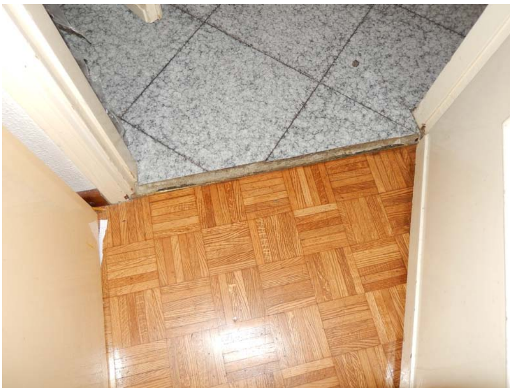
FOTO 21: Interno dell'unità pignorata – Dettaglio dei pavimenti.
