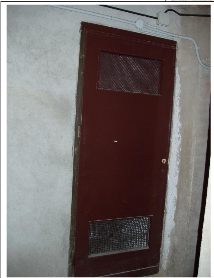
Fotografia n°6 – Vista della porta del vano cantina al piano interrato
