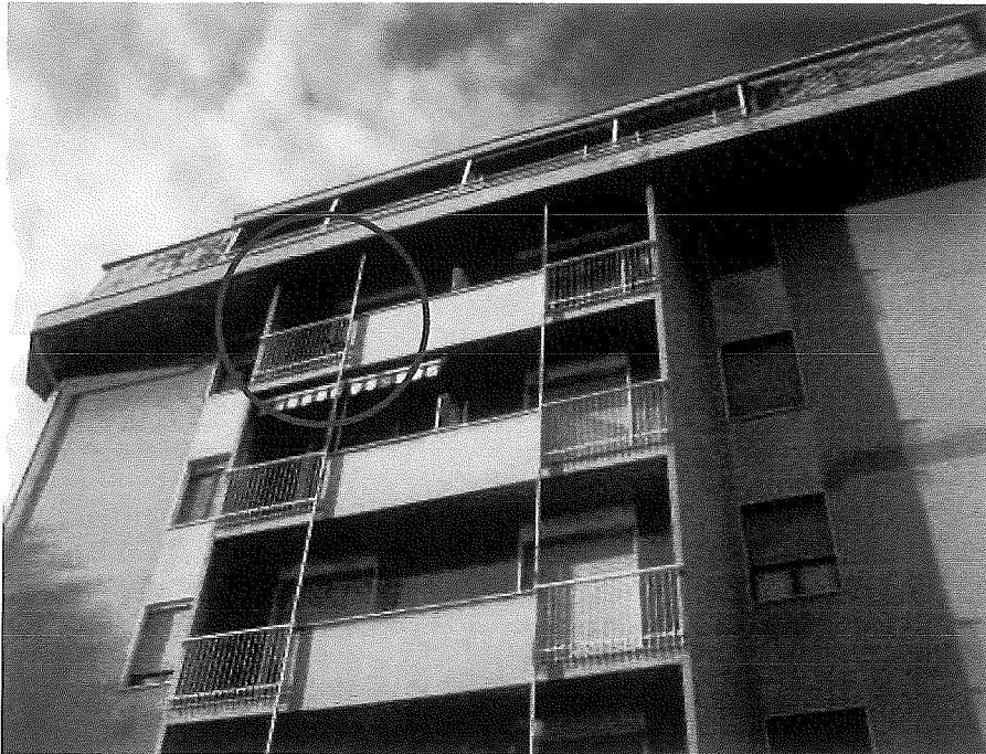
Foto 1. Vista complessiva della facciata con in evidenza l'appartamento in oggetto.
