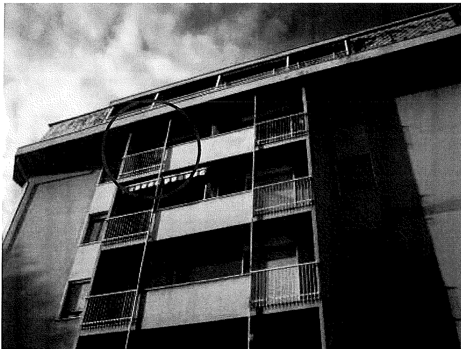
Foto 1. Vista complessiva della facciata con in evidenza l'appartamento in oggetto.
