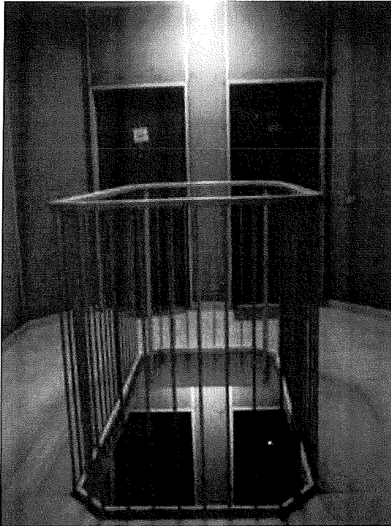
Foto 9. Vista delle scale di accesso e del pianerottolo.
