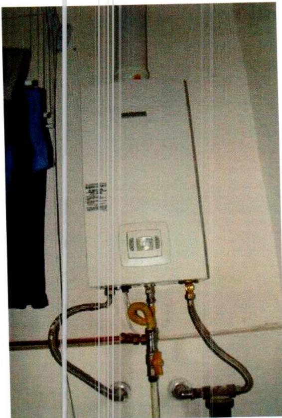
21. Dettaglio della caldaia per la produzione di acqua calda.
