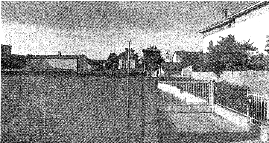
Ingresso carroio da Via Tadini
