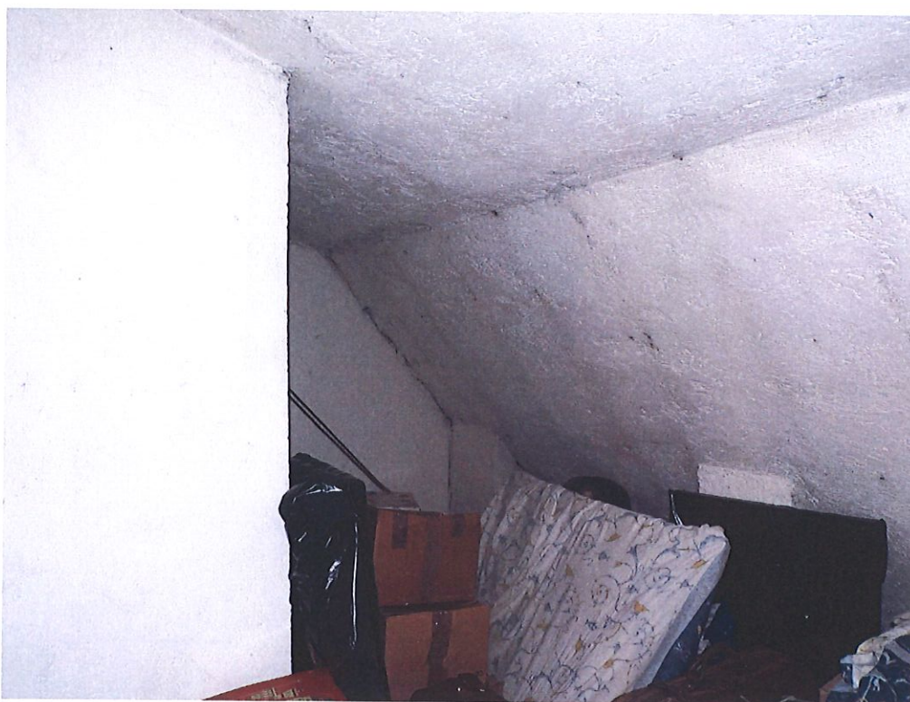
Foto 19 – Il solaio annesso all'appartamento.
