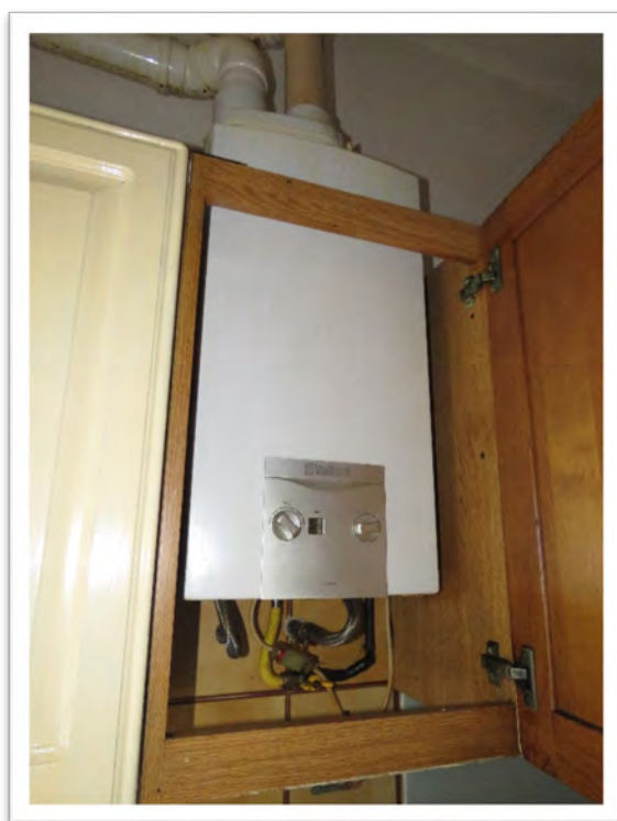
Particolare della caldaia murale a gas e dei cavi elettrici con sezione a vista e scoperta ad altezza di circa ml. 1,00.
