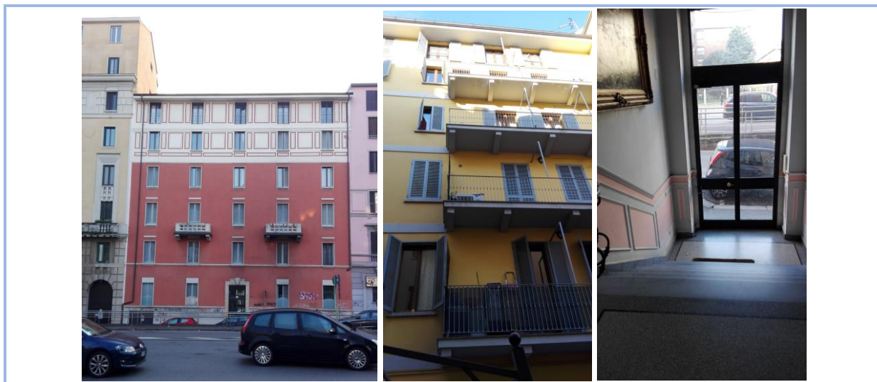
Fig. 3 - 4: prospetto via M. Gioia e cortile interno
