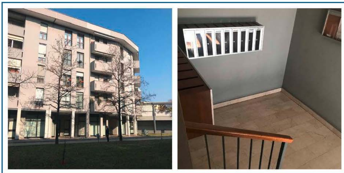
Fig. 3: Edificio di via Sanzio 6/via Caravaggio 6
