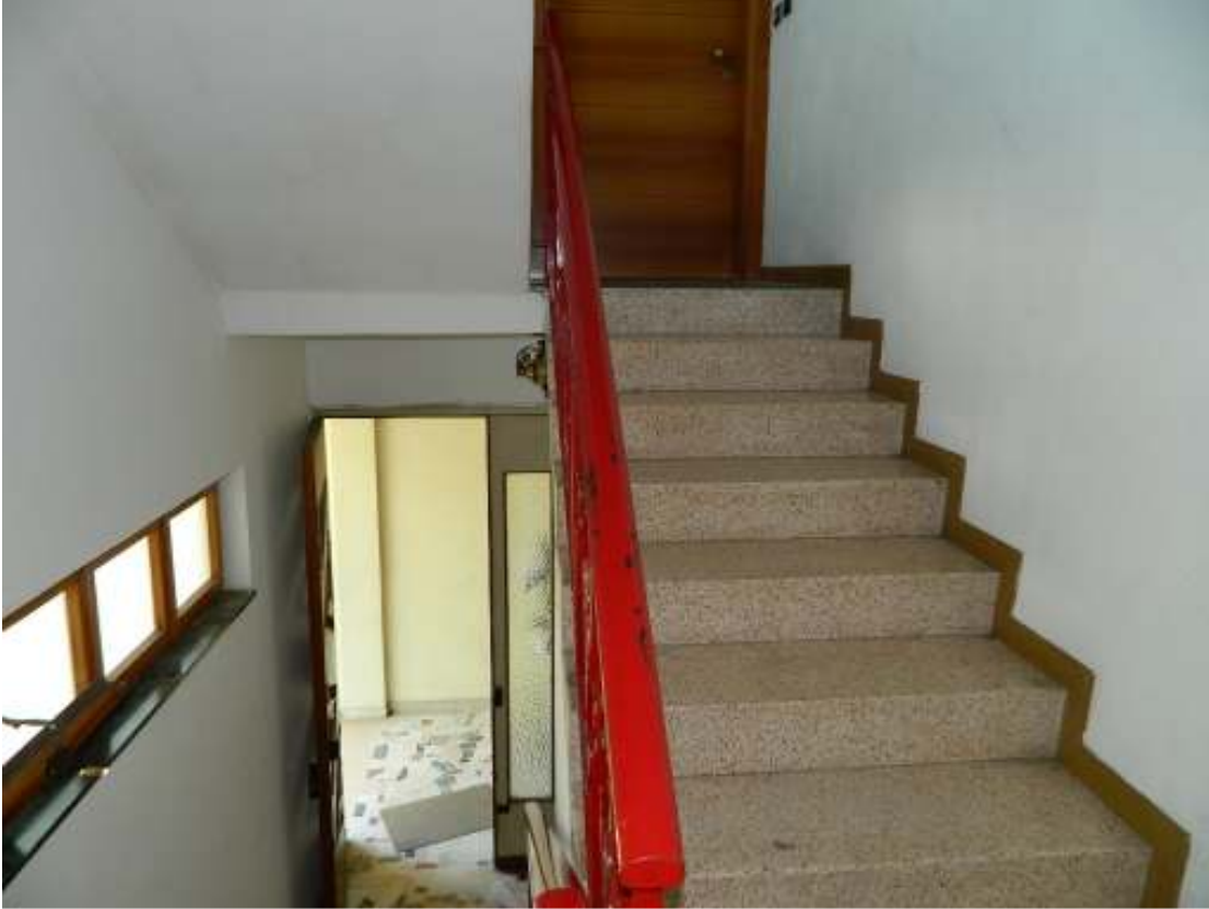
Foto n. 9 – Vano scale di accesso all'unità esecutata.
