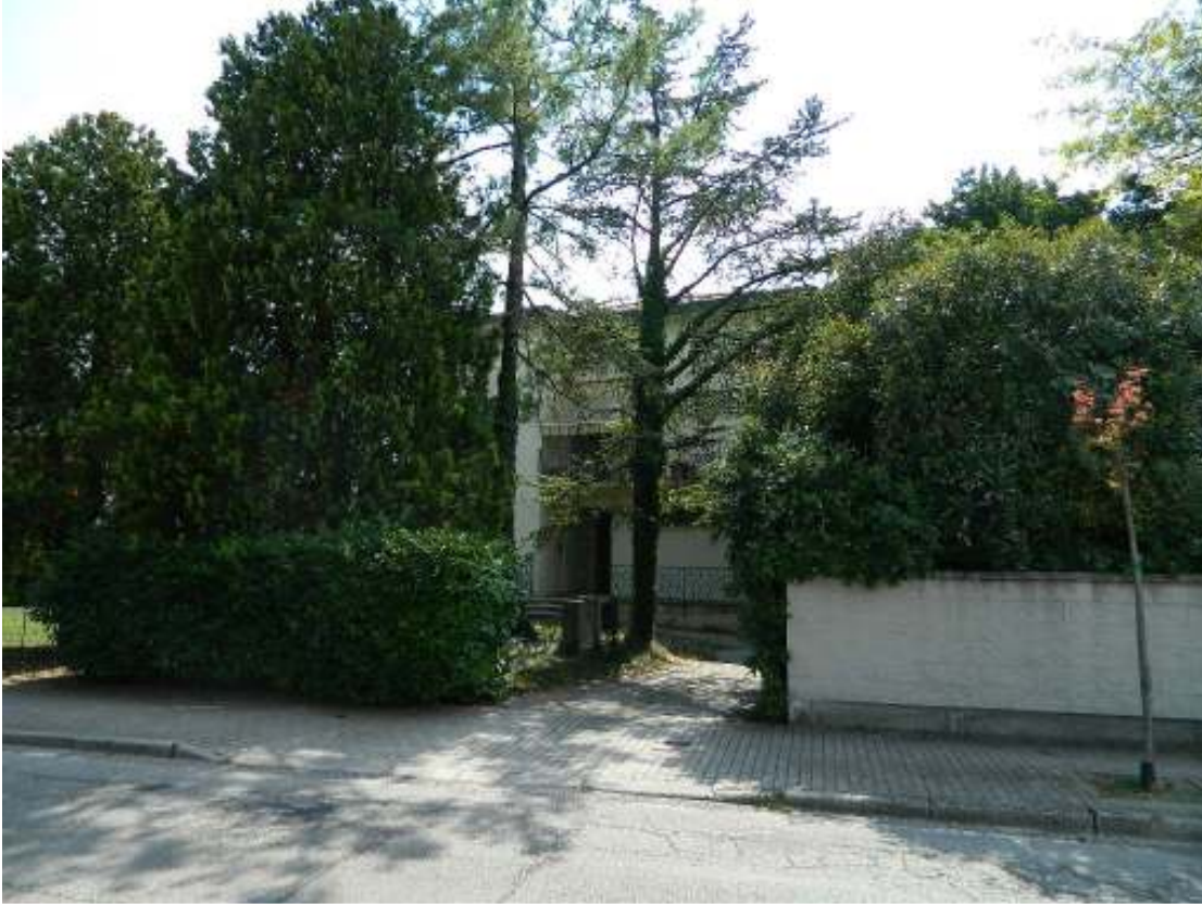
Foto n. 1– Condominio con vista da viale della Repubblica (lato est). In evidenza il varco d'accesso.
