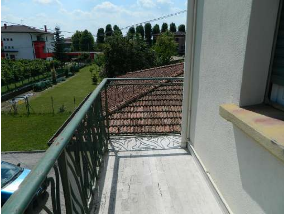
Foto n. 33 – Vista ovest dal terrazzino lato sud, accessibile dalla cucina e dal soggiorno.
