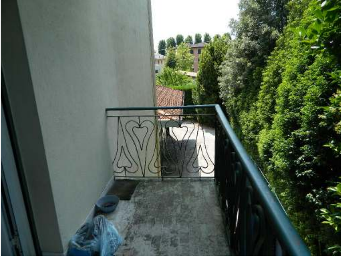
Foto n. 19 – Terrazzo della camera lato nord, vista ovest.
