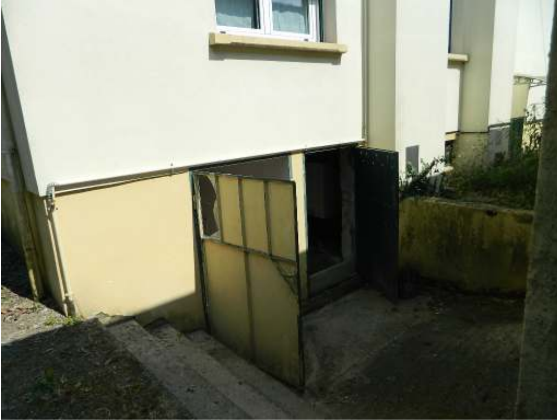
Foto n. 35 – Accesso vani accessori: in evidenza scalinata di accesso e serramenti.
