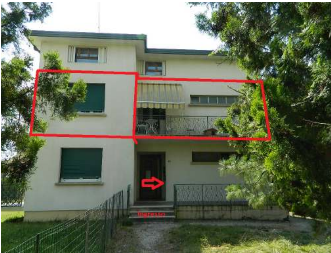
Foto n. 6 – Lotto esecutato evidenziato in rosso (lato est).
