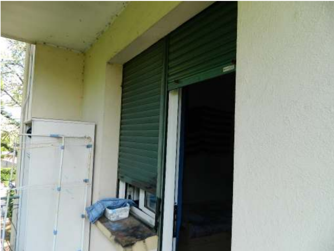
Foto n. 20 – Terrazzo della camera lato nord, vista est.
