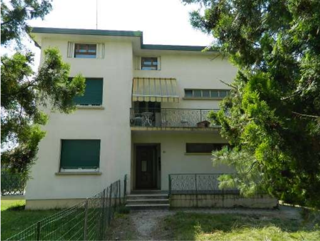
Foto n. 3 – Condominio con vista dal giardino comune (lato est).
