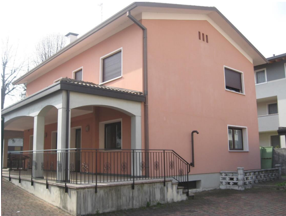
Raccordo del porticato con quota campagna a lato est
