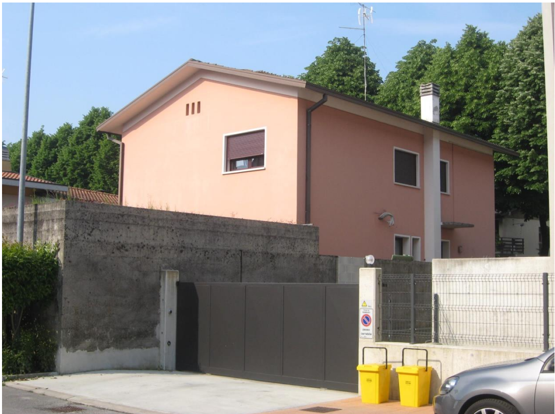
La parete nord e parte della parete est del garage
