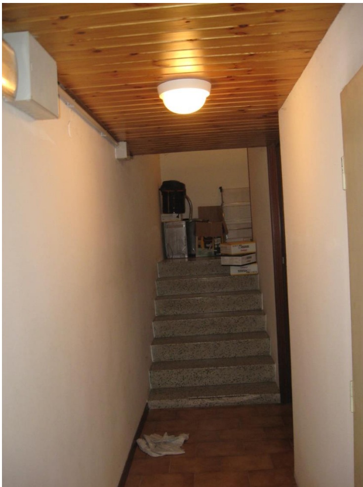
La scala che dal piano interrato conduce al piano terra
