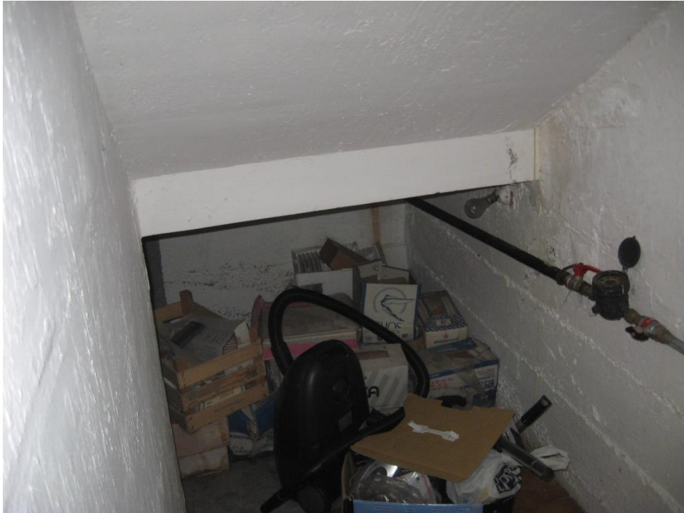
Il sottoscala al piano interrato
