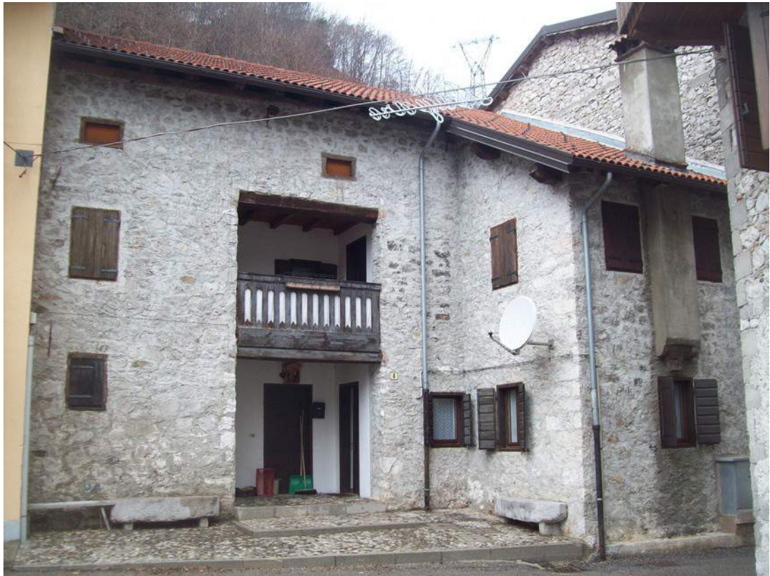
Foto 3: Prospetto Est fabbricato
