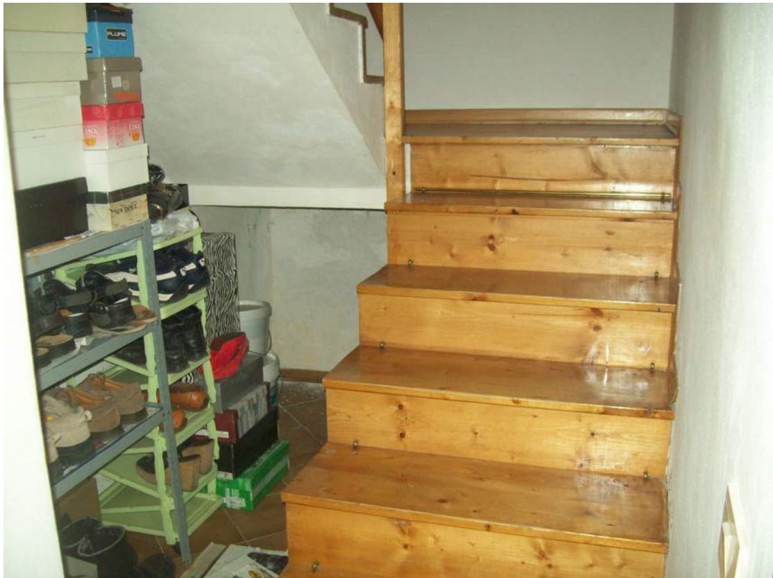
Foto 10: Vano scale al piano terra
