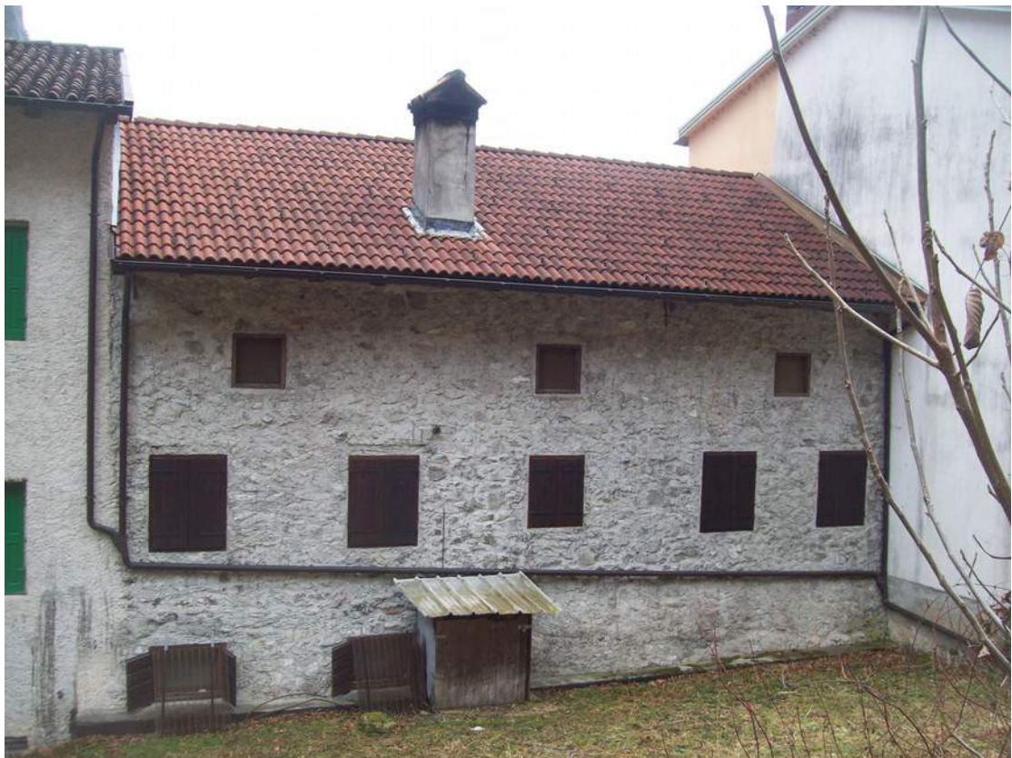
Foto 4: Prospetto Ovest fabbricato
