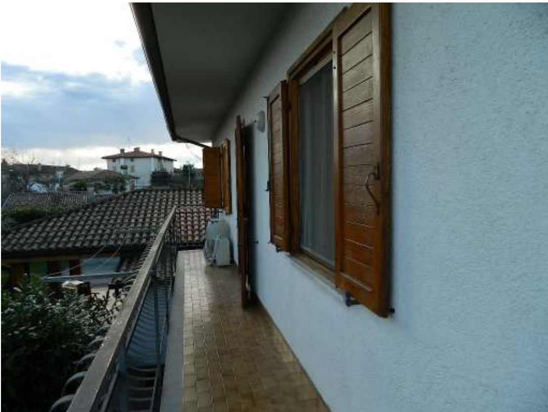
Foto n. 32 – Terrazzo piano primo vista verso ovest.
