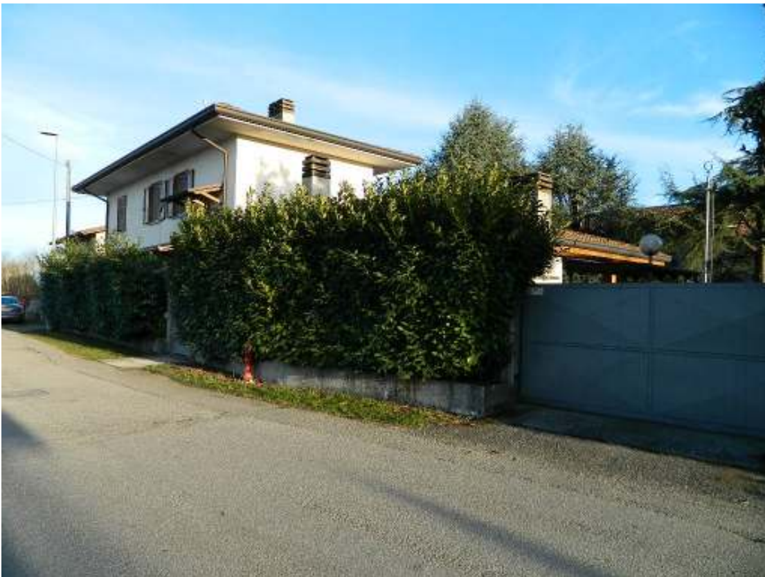
Foto n. 2 – Vista da nord ovest da via Monte Santo. In evidenza accesso pedonale.
