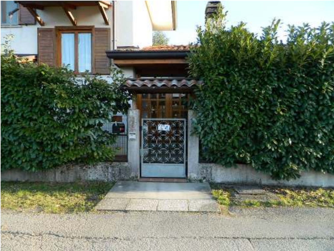
Foto n. 7 – Ingresso pedonale da via Monte Santo (lato nord).
