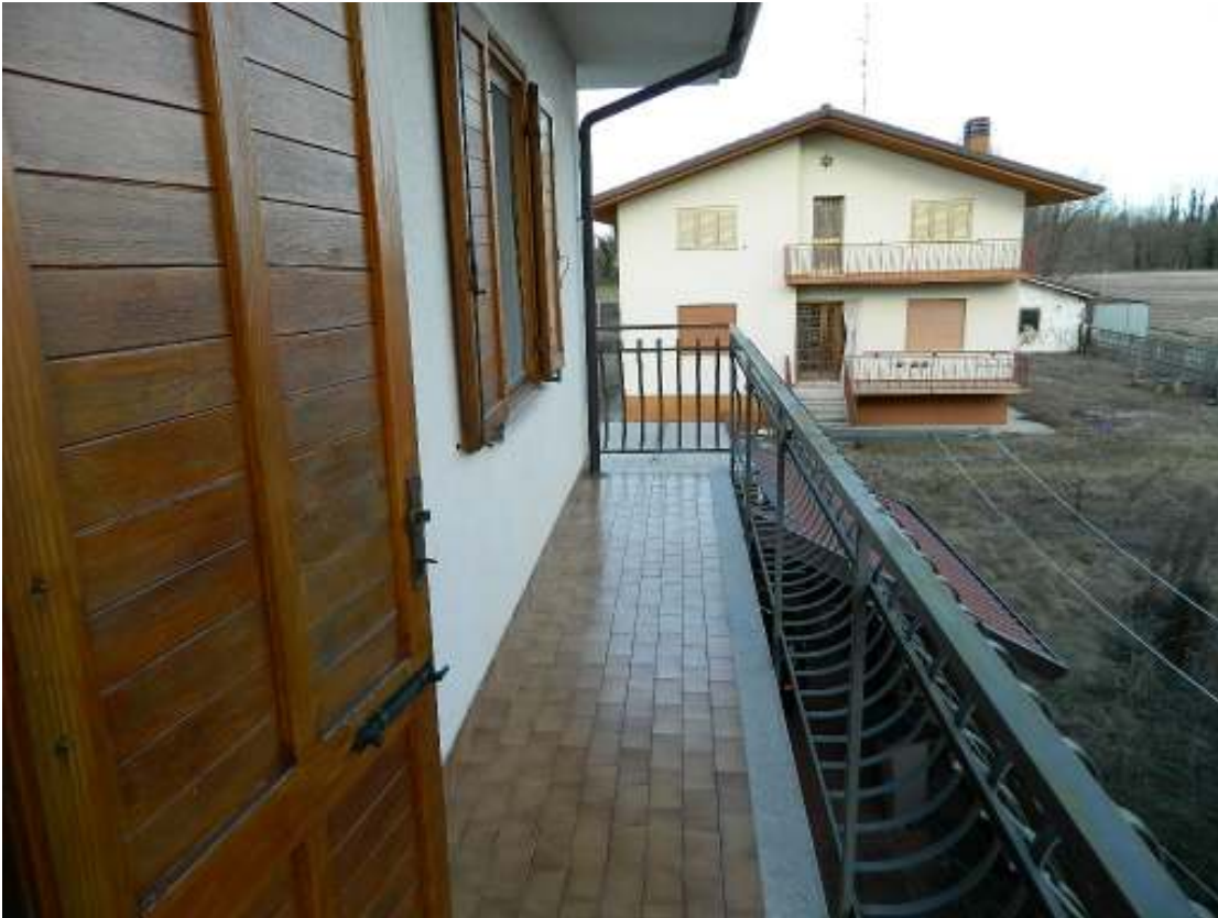
Foto n. 33 – Terrazzo piano primo vista verso est.
