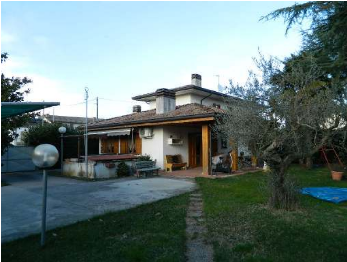
Foto n. 3 – Vista dall'interno area di pertinenza (lato sud ovest).
