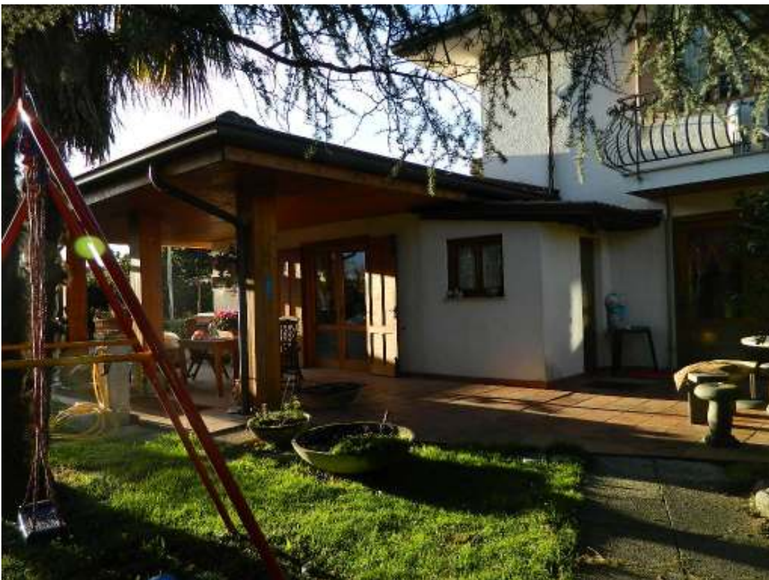
Foto n. 4 – Vista dall'interno area di pertinenza (lato sud est).
