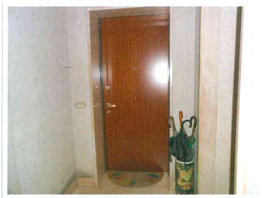
Foto 6 porta ingresso all'immobile
