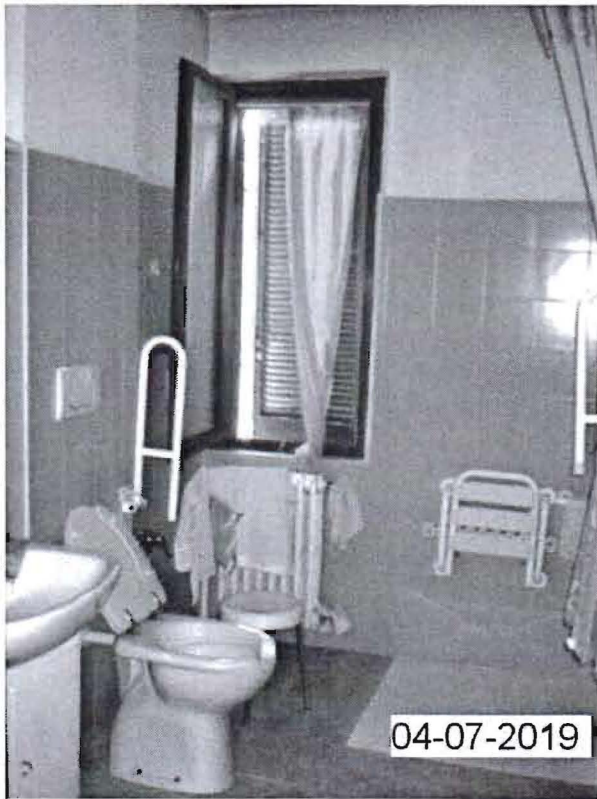
Foto 14: Abitazione – bagno – piano primo
