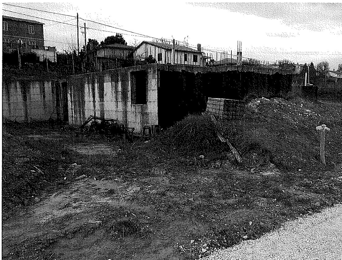
Edificio E: bifamiliare
