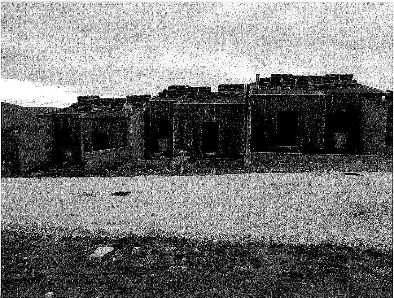
Edificio A: trifamiliare
