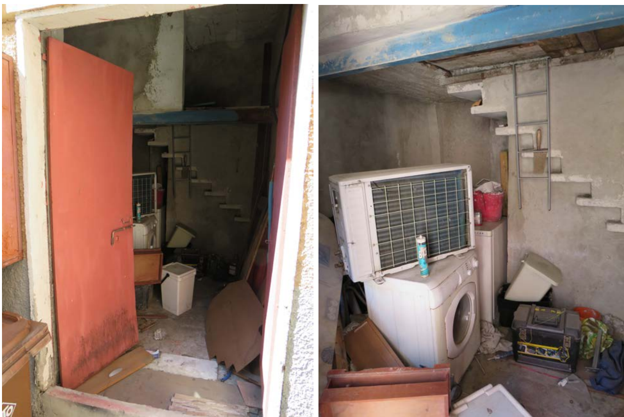
INGRESSO SCANTINATO A PIANO TERRENO
