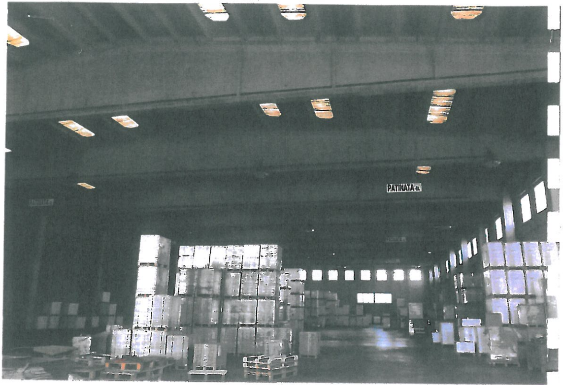
CAPANNONE PREFABBR. INTERNO
