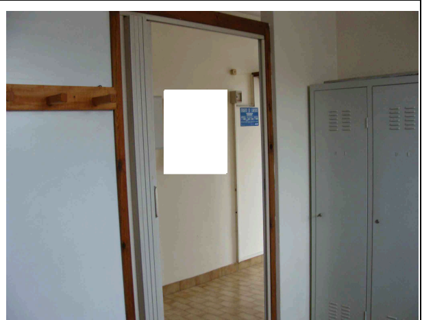
Spogliatoio p. T
