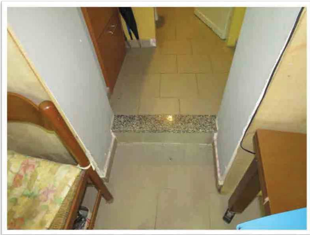
Particolare disimpegno della zona notte e caldaia.
