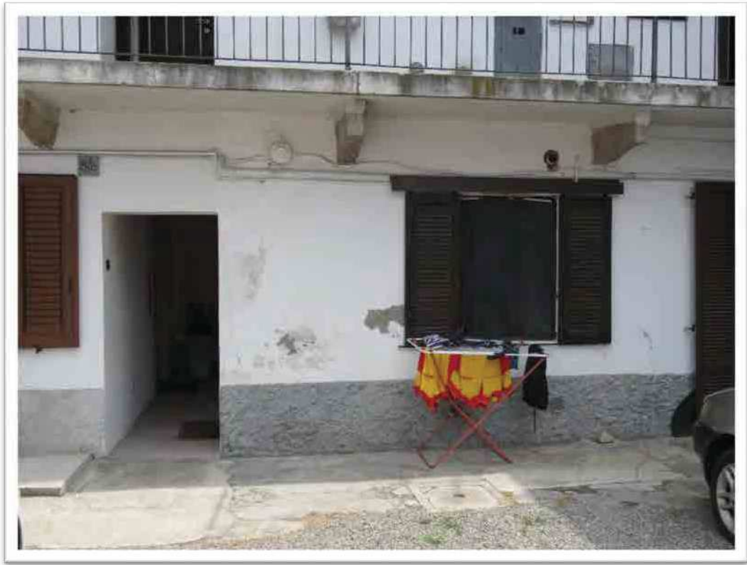
L'ingresso al disimpegno 8/b e ingresso all'alloggio.
