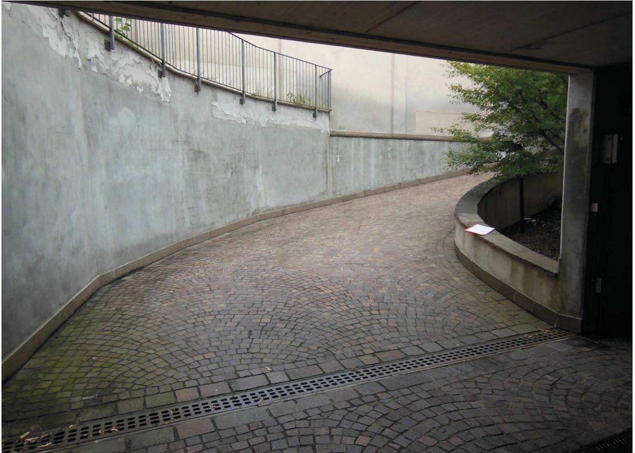
Foto 5: rampa d'accesso ai boxes
