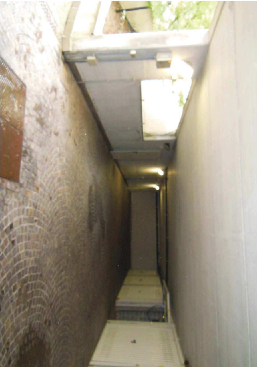
Foto 6: corsello comune d'accesso ai boxes
