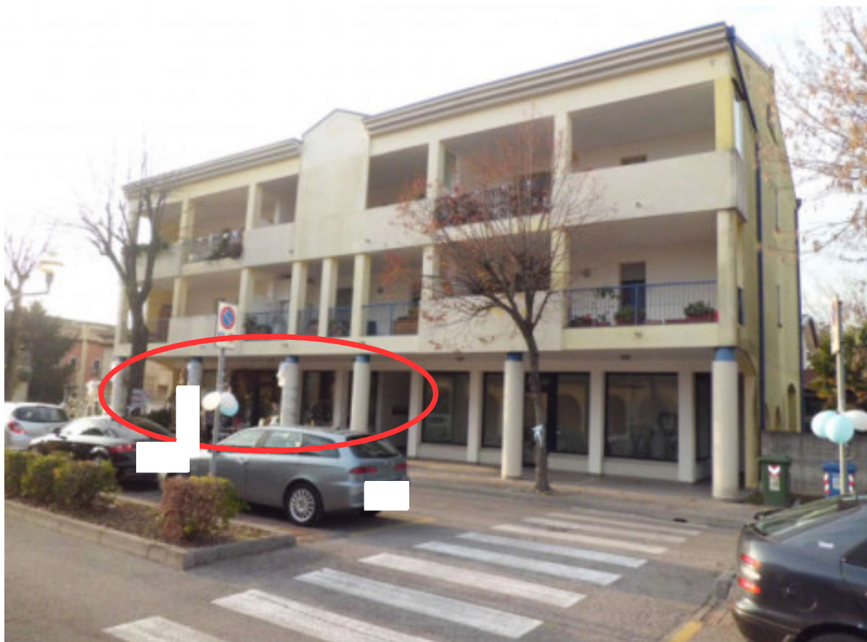
Foto n° 1 - 21/11/2017 - Comune di San Michele al Tagliamento, foglio 24, part. 1114 - Visione esterna del condominio denominato "Ai Portici". L'immobile pignorato si trova al piano terra. Foto scattata dalla strada pubblica Via della Pace.
