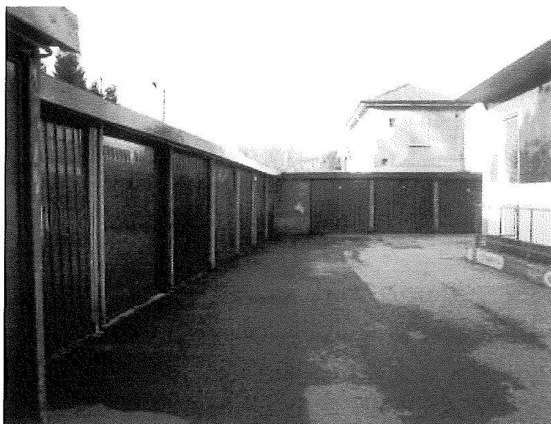
Figura 6. Vista delle autorimesse sul lato Ovest del condominio.
