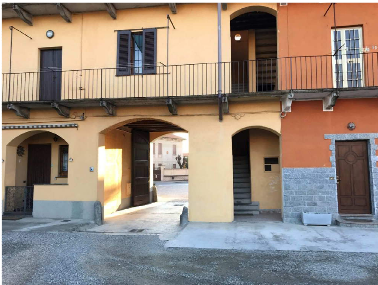
Androne e vista scala accesso all'unità immobiliare
