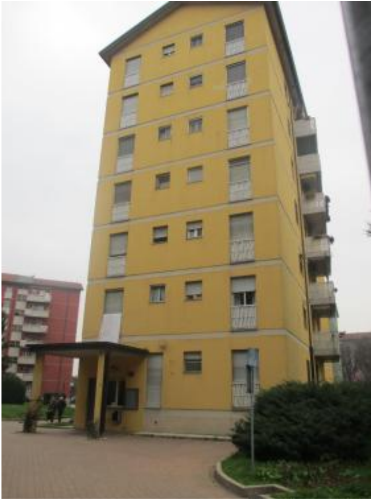
Foto 1: ingresso scala E viale Ungheria, 21 Milano
