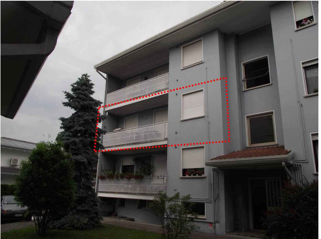
Foto 3 - prospetto principale ed ingresso
