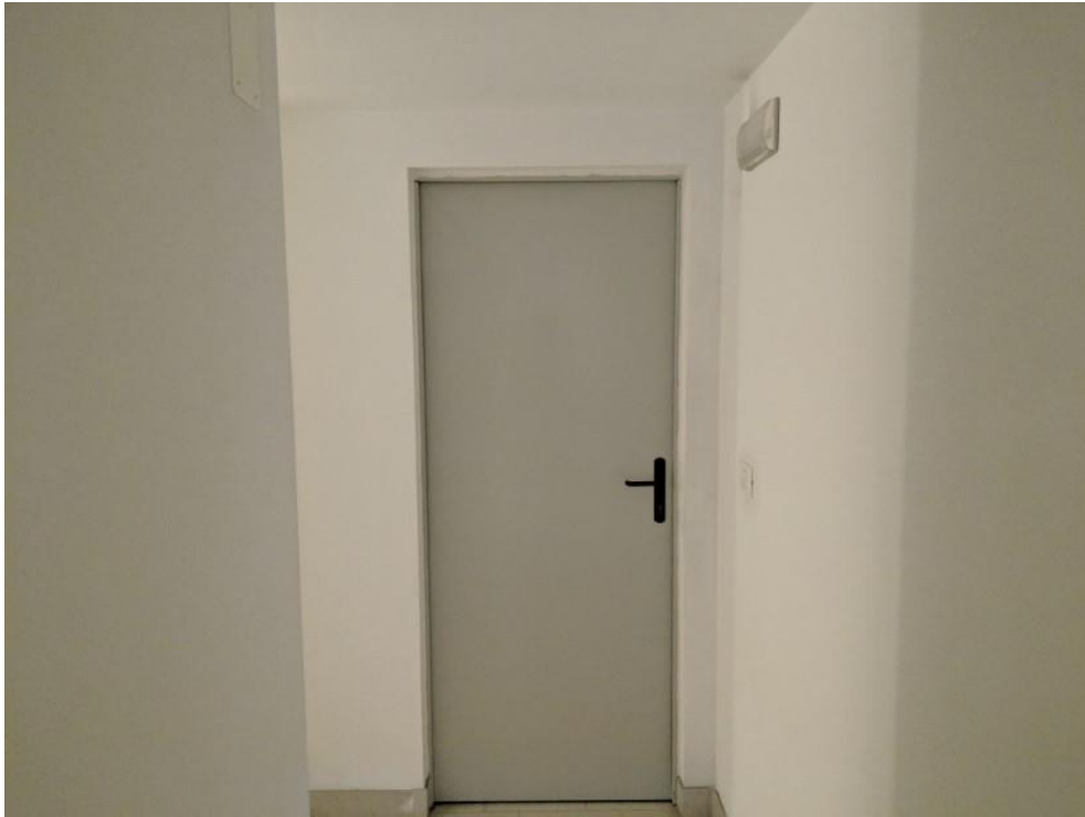
FOTO 35: ACCESSO GARAGE DA CANTINE (Subalterno n. 9 – P.Int.)
