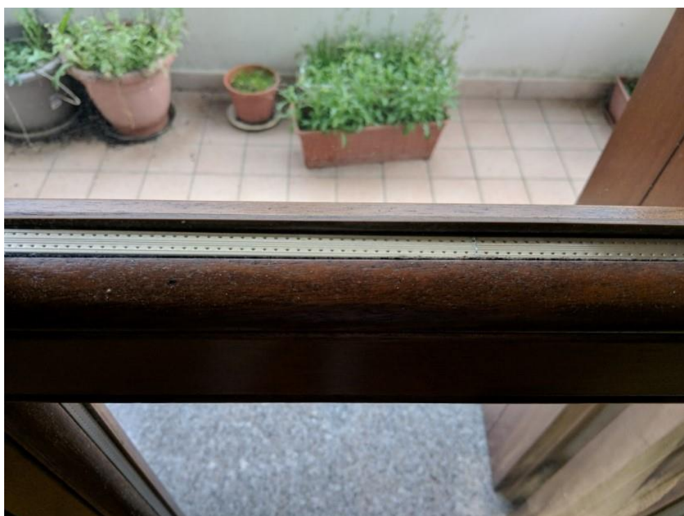
FOTO 24: PARTICOLARE SERRAMENTO (Subalterno n. 1 – P.T.)
