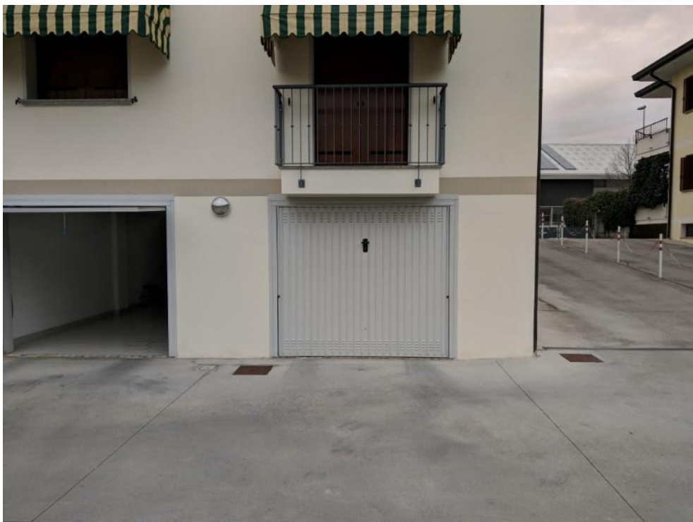
FOTO 36: ACCESSO CARRAIO DEL GARAGE (Subalterno n. 9 – P.Int.)
