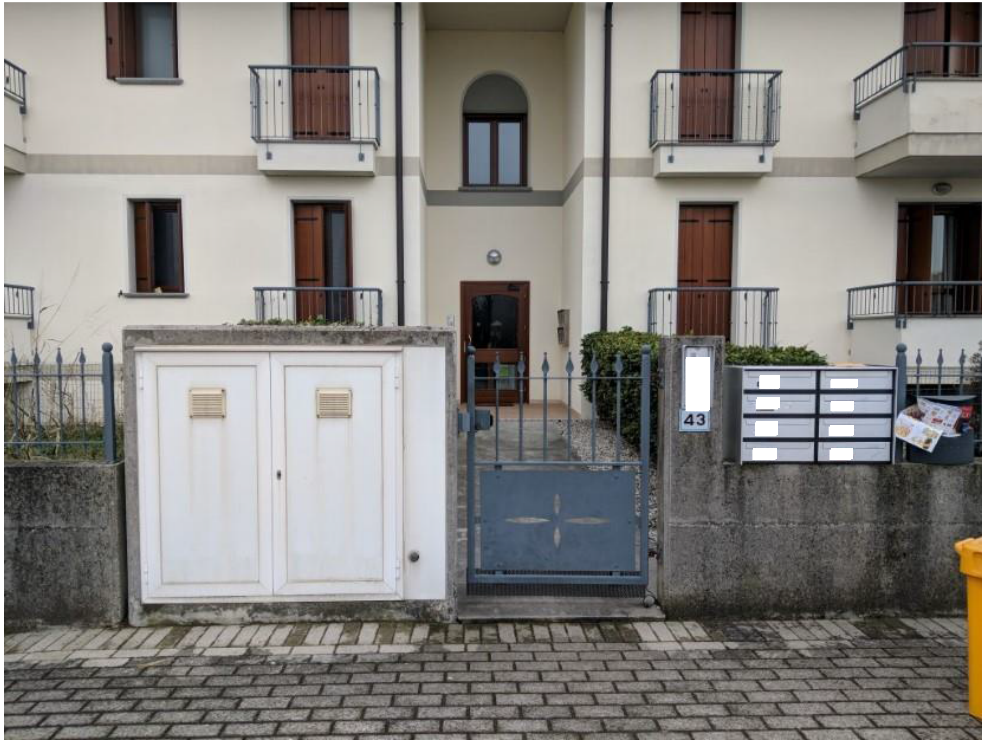
FOTO 5: ACCESSO PEDONALE CONDOMINIALE
