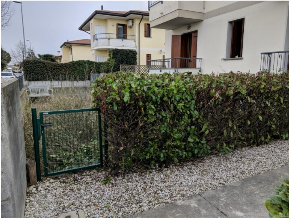
FOTO 29: PANORAMICA E ACCESSO CORTE DEL SUBALTERNO N. 1
