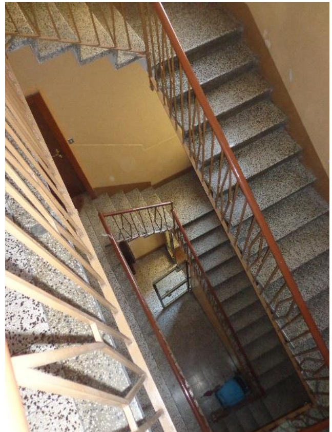
Particolari delle pavimentazioni in palladiana rilevate in tutte le parti comuni; scale realizzate con gradini a sbalzo e fornite di balaustre metalliche e corrimano lignei.
