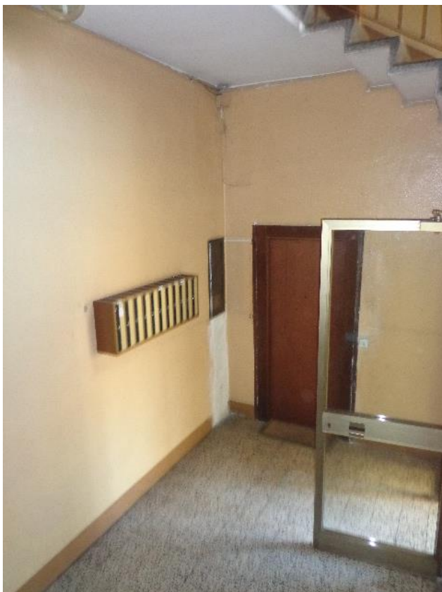
Particolari delle pavimentazioni in palladiana rilevate in tutte le parti comuni; scale realizzate con gradini a sbalzo e fornite di balaustre metalliche e corrimano lignei.
