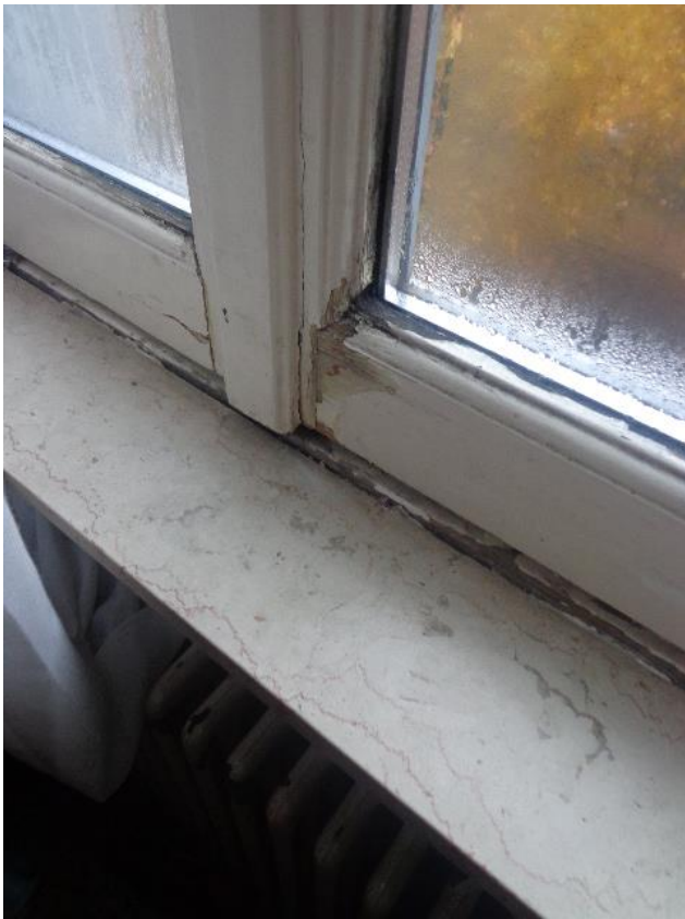
Particolari degli infissi esterni lignei operati con l'inserimento di doppi vetri; davanzali in marmo e presenza di radiatori metallici riconducibili all'età di fabbricazione dell'intero stabile.
