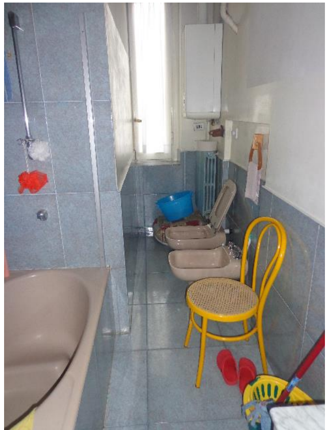
Particolari dell' accesso all'unico bagno presente dove è collocata la caldaia a muro tipo "turbo" atta alla produzione di acqua calda sanitaria e riscaldamento.
