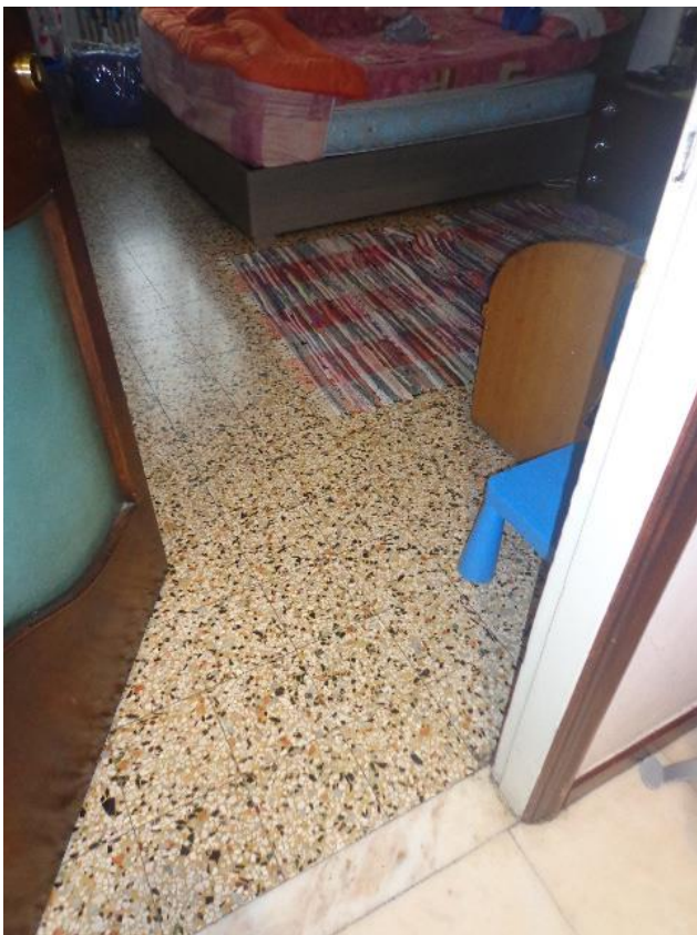
Accesso alla seconda camera da letto matrimoniale; pavimentazione in palladiana ed infissi lignei vetriati riconducibili all'età di fabbricazione dell'intero stabile.
