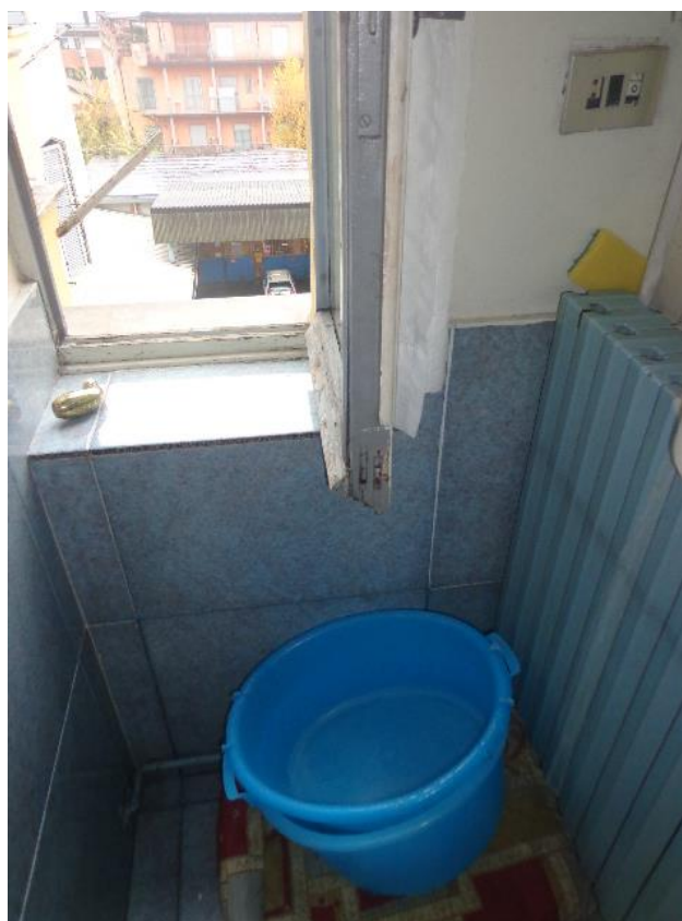
Particolari dell'infisso ligneo, con vetri semplici, rilevato nel locale bagno.
