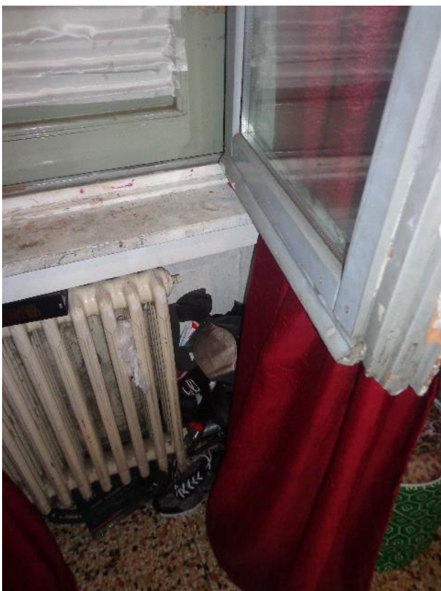
Particolari degli infissi lignei, dei radiatori e della pavimentazione, riconducibili all'età di fabbricazione dell'intero stabile (infissi lignei esterni operati con l'inserimento di doppi vetri).
