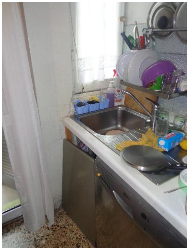
Particolari del locale giorno e dell'angolo cottura ricavato al suo interno; particolari della pavimentazione in palladiana, del lavello e degli infissi esterni in alluminio, con doppi vetri, di recente sostituzione..
