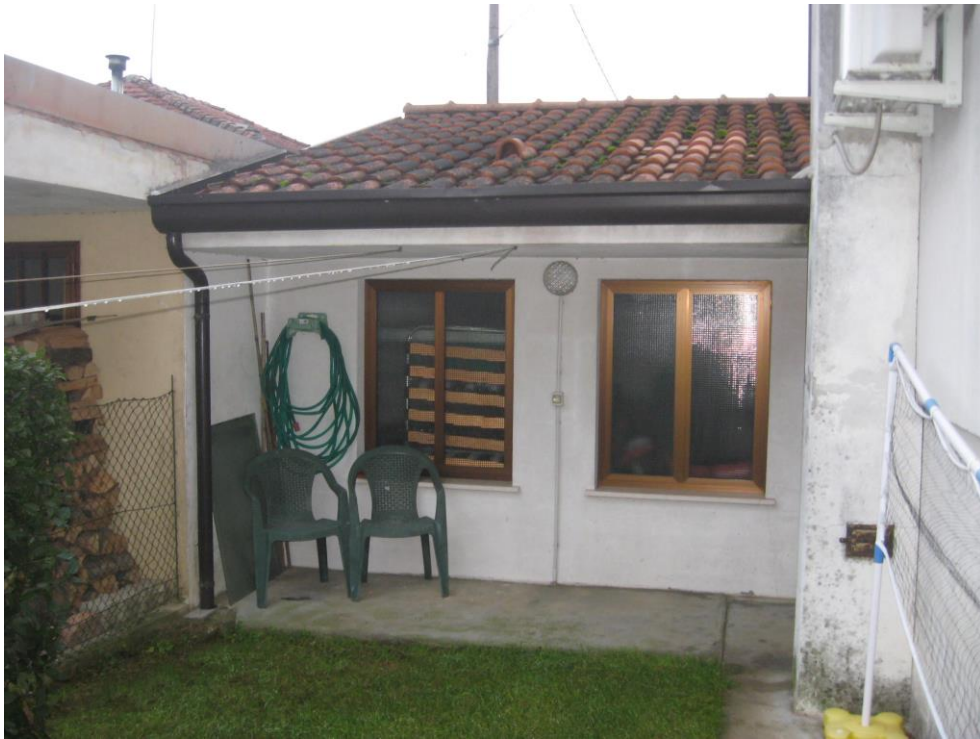
L'autorimessa sul fronte retro
