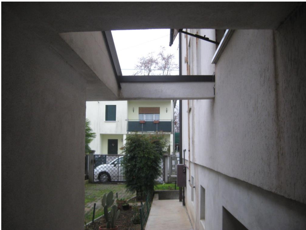
L'intercapedine tra autorimessa e corpo principale
