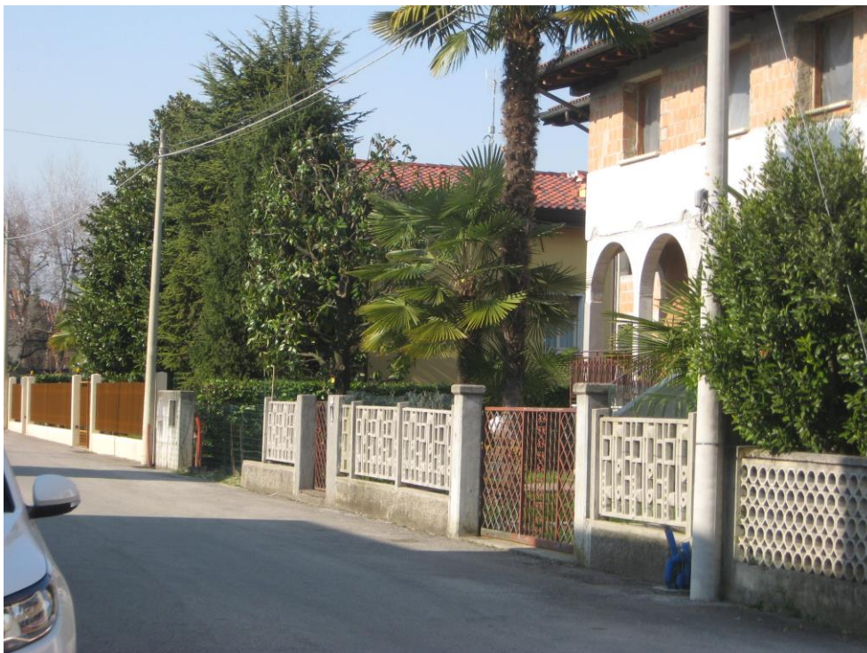
Si nota l'accesso carraio, l'accesso pedonale e parte della recinzione demolita
