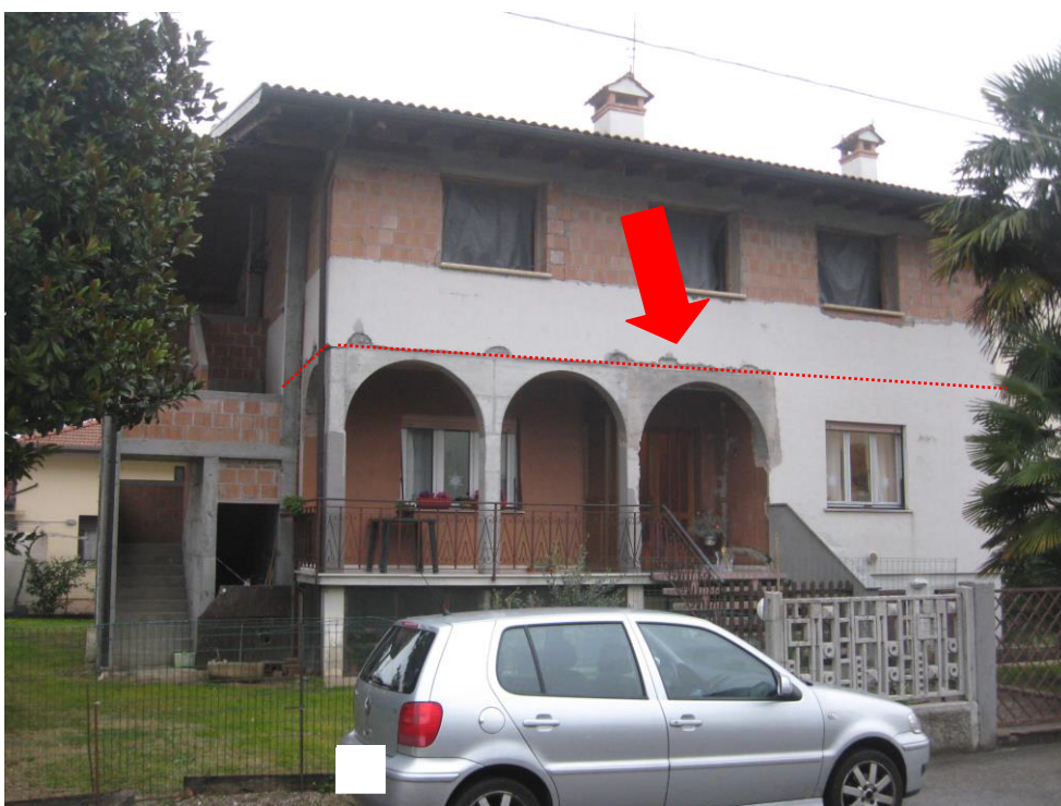
Vista da via Ortigara – a lato sx la scala che conduce al piano primo
