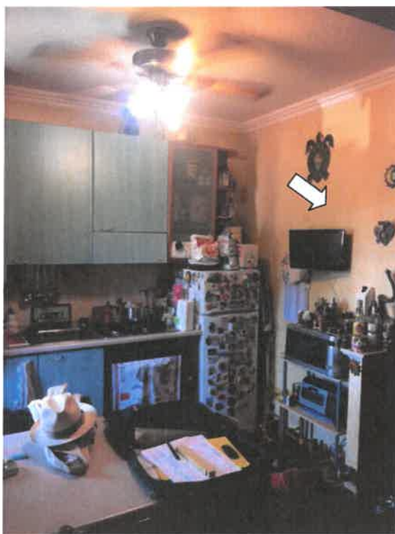
PARETE IN LEGNO
