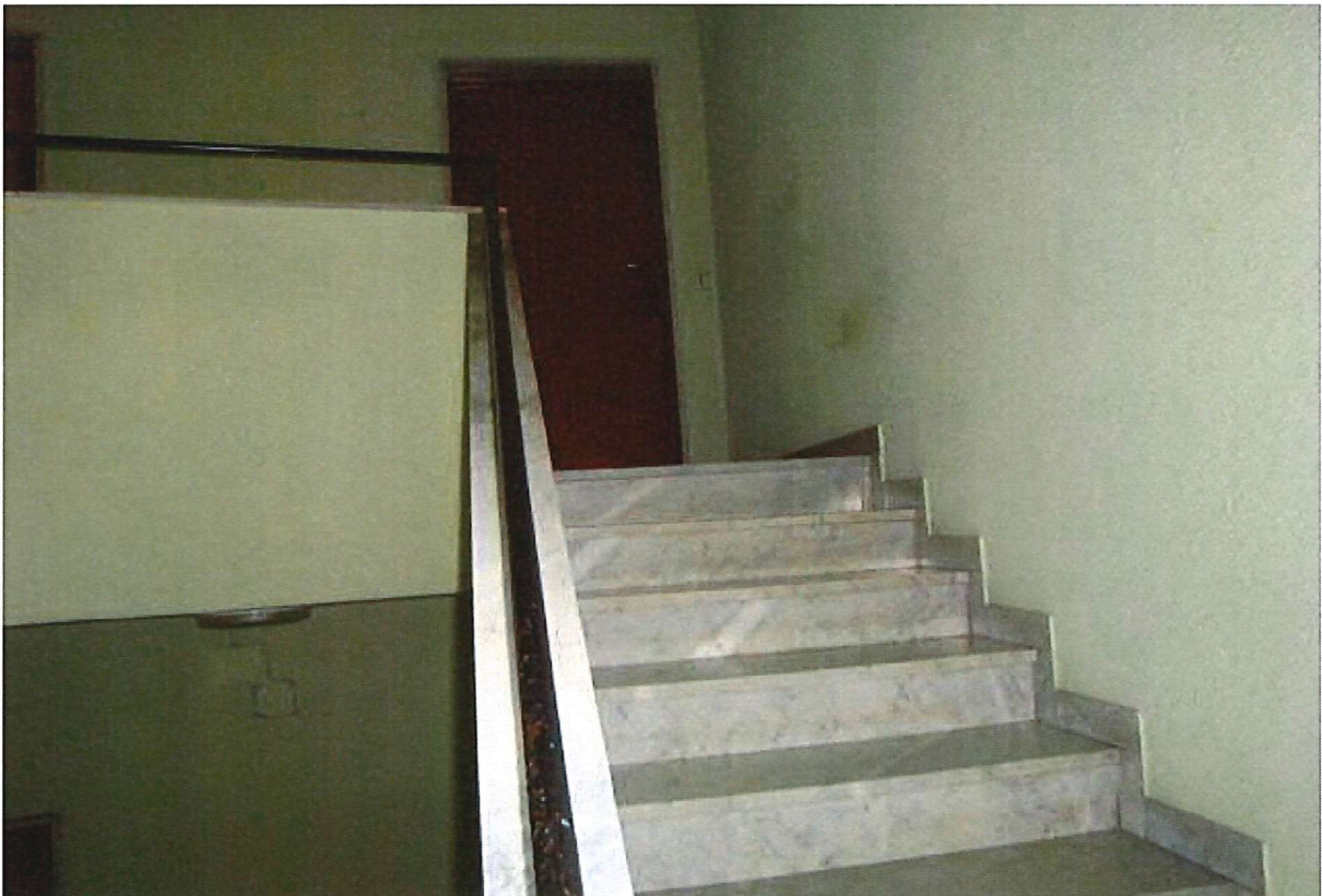
R.G.E. 1732/2016, Giudice Dott. G. Fiengo Rozzano, Via G. Mazzini n.° 56, piano 4°-S1, Foglio 23, mapp. 65, sub. 22 Prospetti interni: l'androne di ingresso e le scale condominiali
