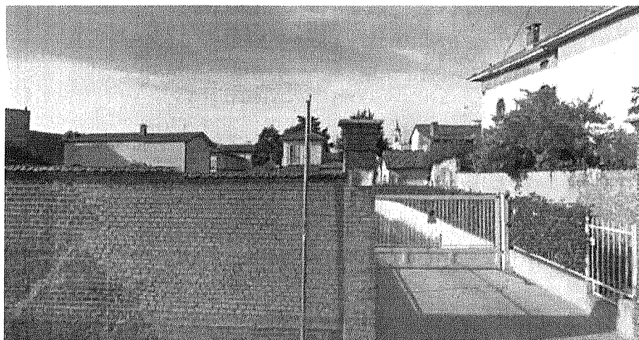
Ingresso carroio da Via Tadini
