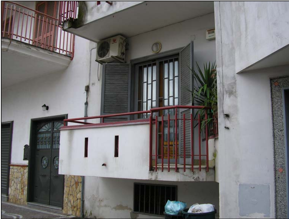
Fotografia n. 3 – Esterno dei fabbricato con particolare riferimento al balcone lato ingresso.
