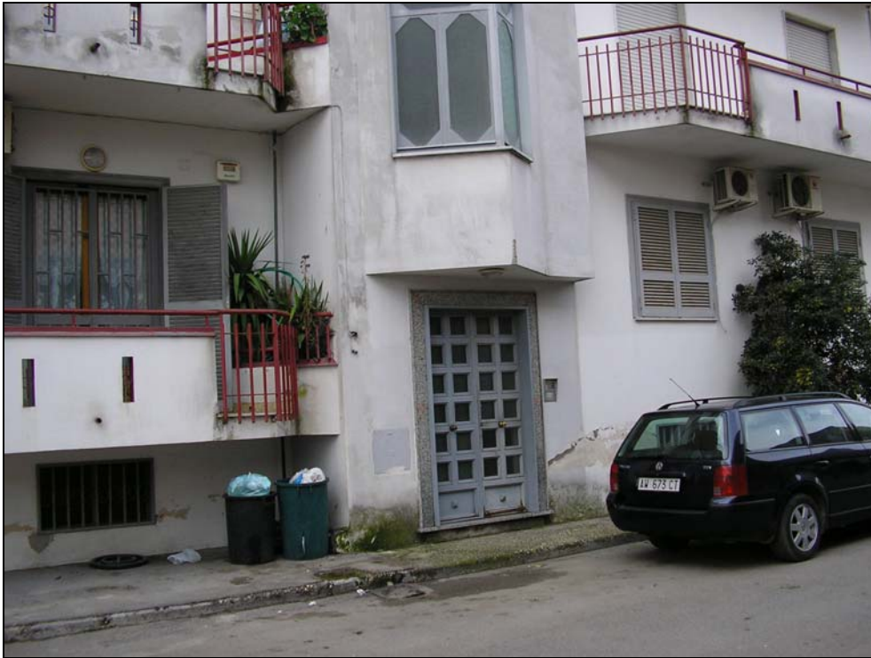
Fotografia n. 1 – Esterno del fabbricato lato ingresso
