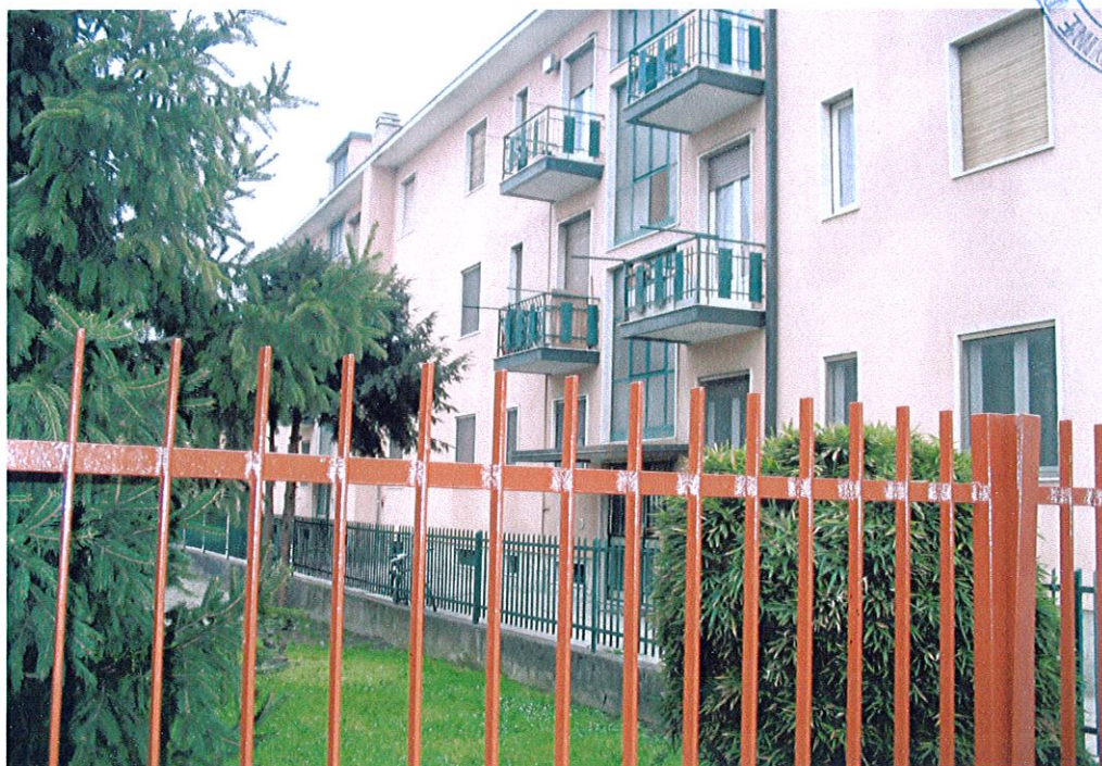
facciata ingresso scala "A"
