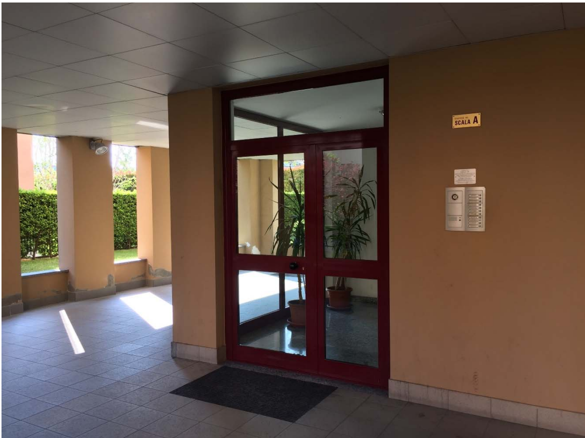
Foto 06 - Ingresso al piano terra del fabbricato (scala A)
