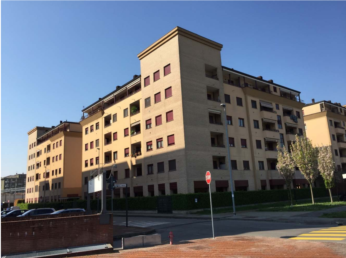
Foto 01 - Il complesso su via Gabriele D'Annunzio e via alla Stazione
