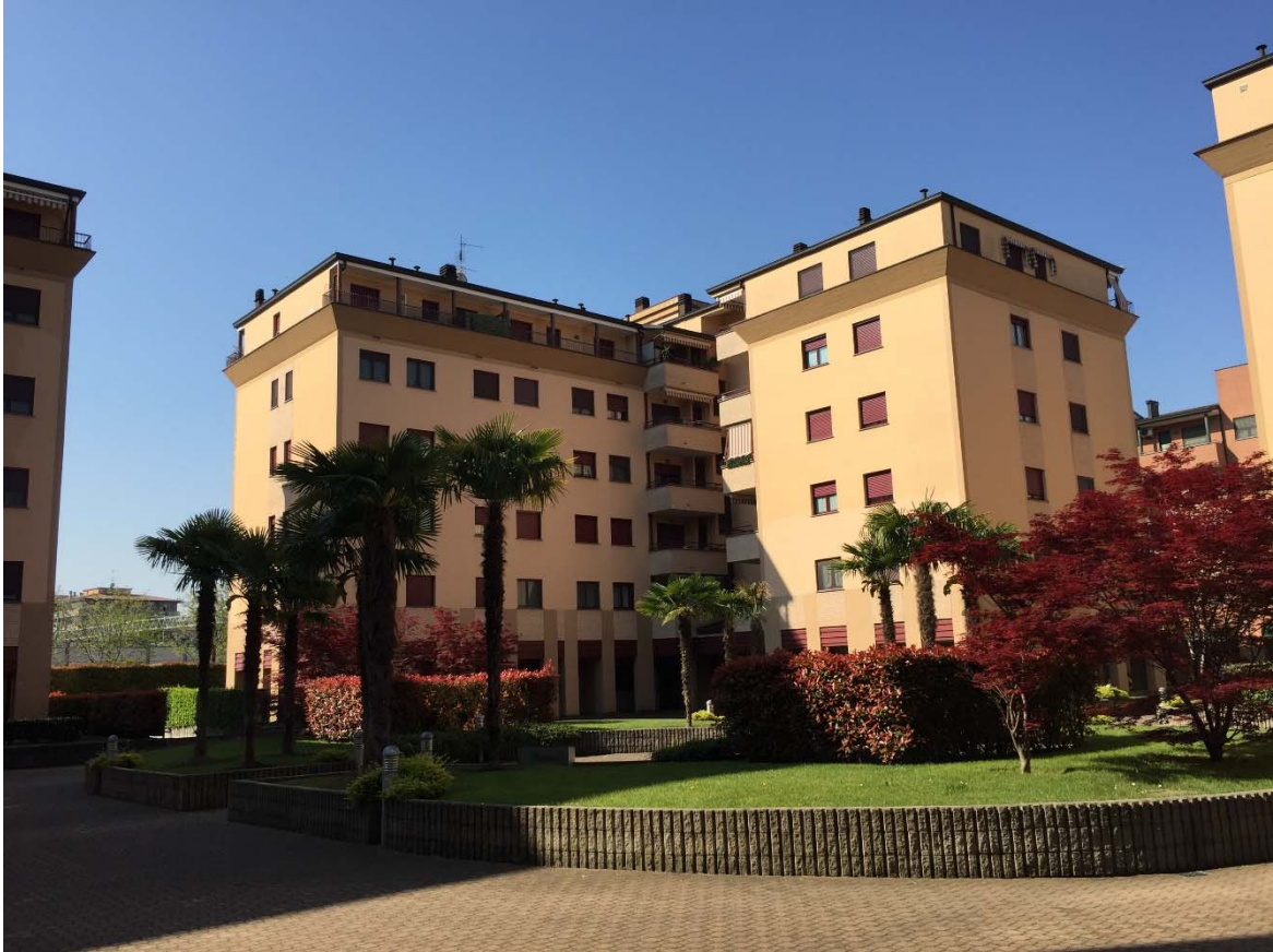
Foto 05 - Il fabbricato dalla corte comune (edificio D1)
