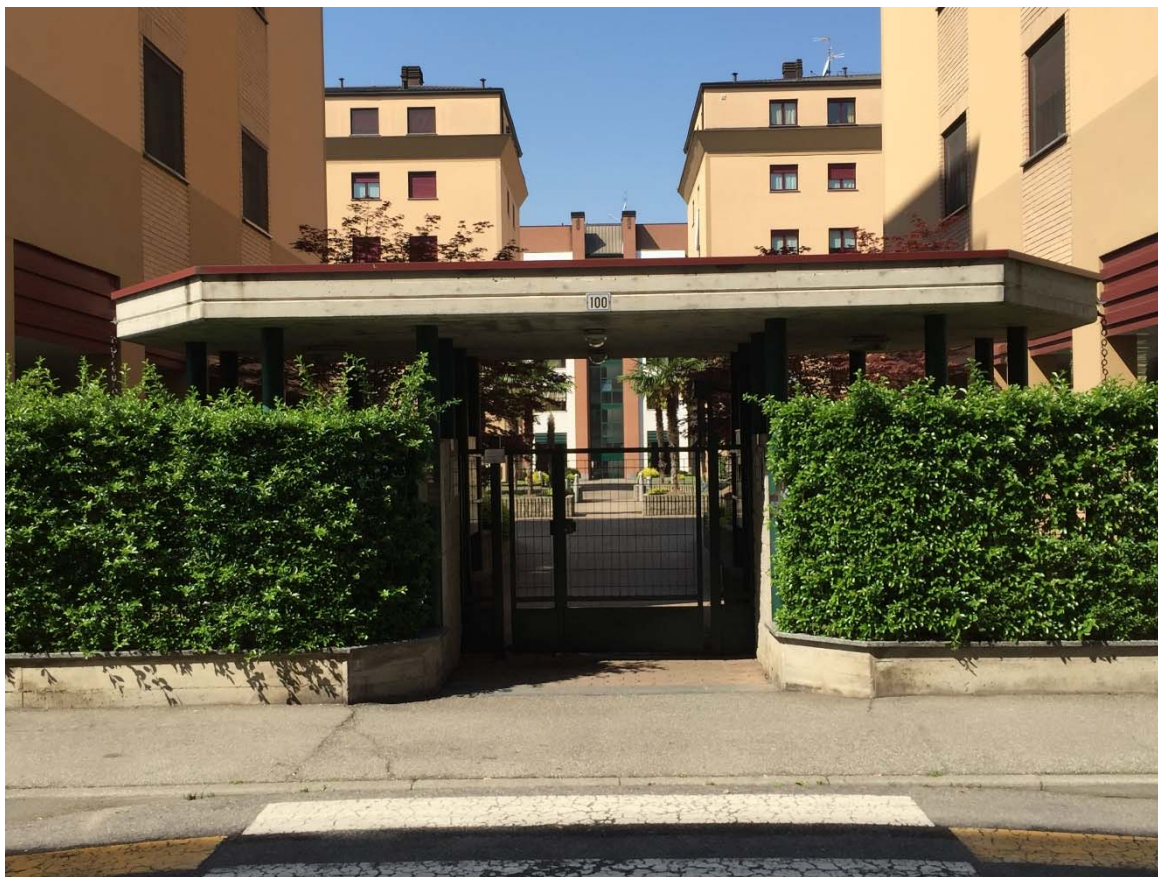
Foto 03 - Ingresso al complesso al civico 100 di via Gabriele D'Annunzio
