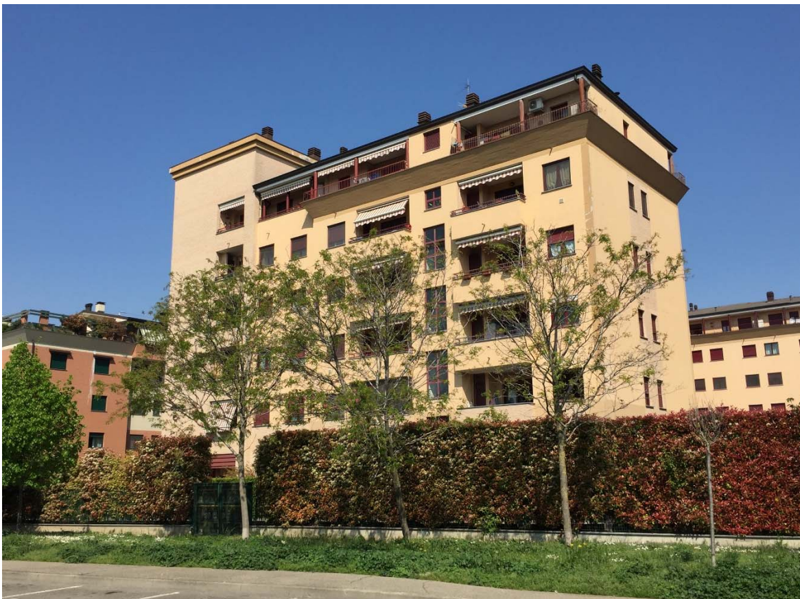
Foto 02 - Il fabbricato su via Bruno Munari
