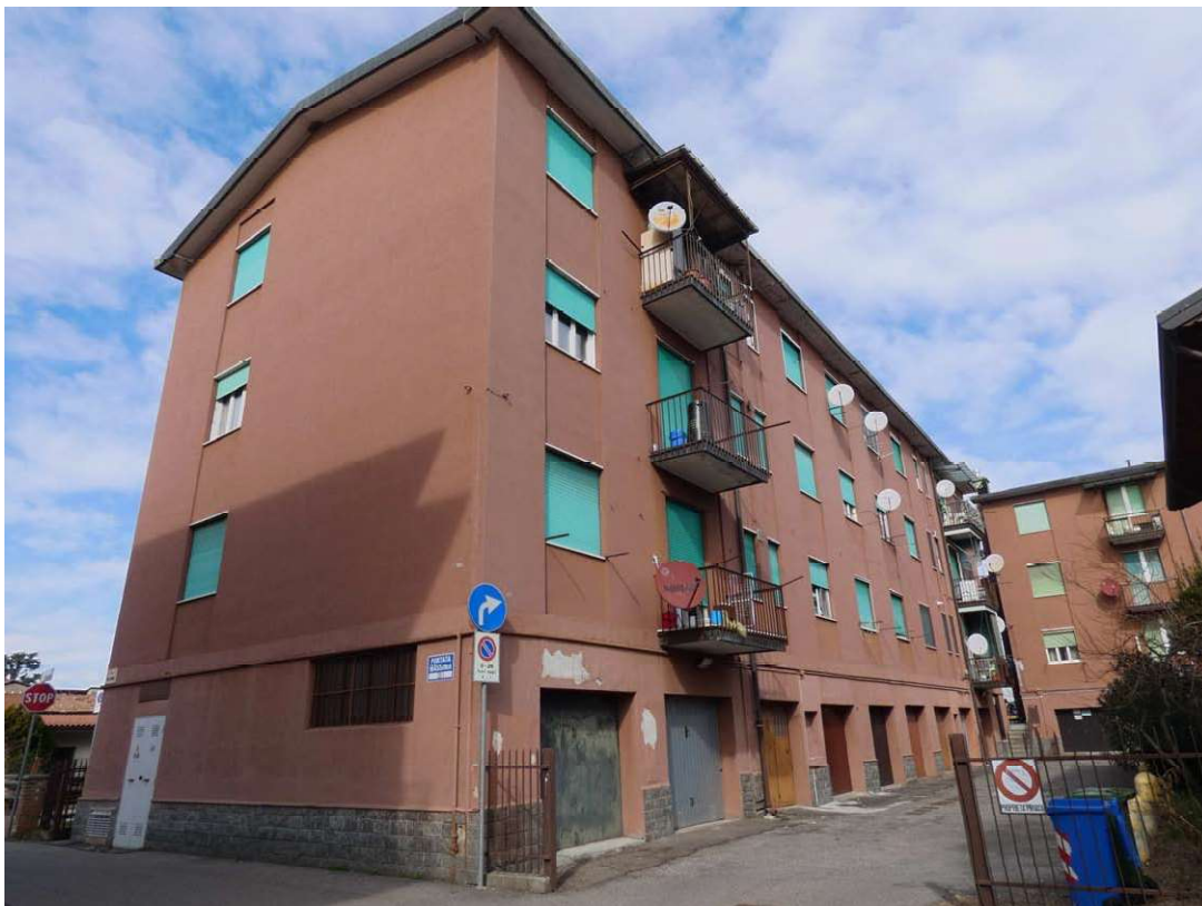
Foto 2: prospetto lato cortile
