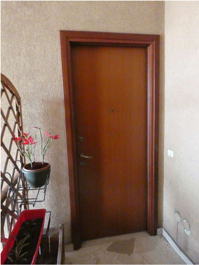
Foto 6: porta d'accesso all'appartamento
