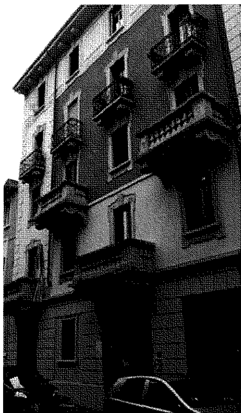
Foto 1 Ingresso da Via Regaldi 22
