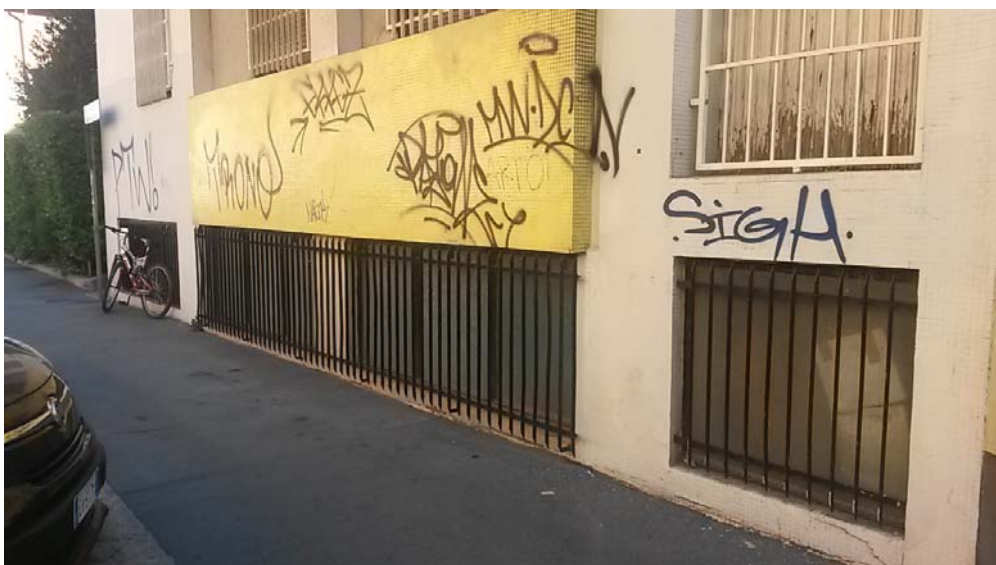
PARTICOLARE ESTERNO IMMOBILE
