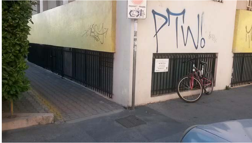
PARTICOLARE ESTERNO IMMOBILE
