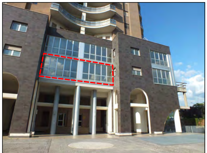
Foto n.ro 4 Prospetto Sud
