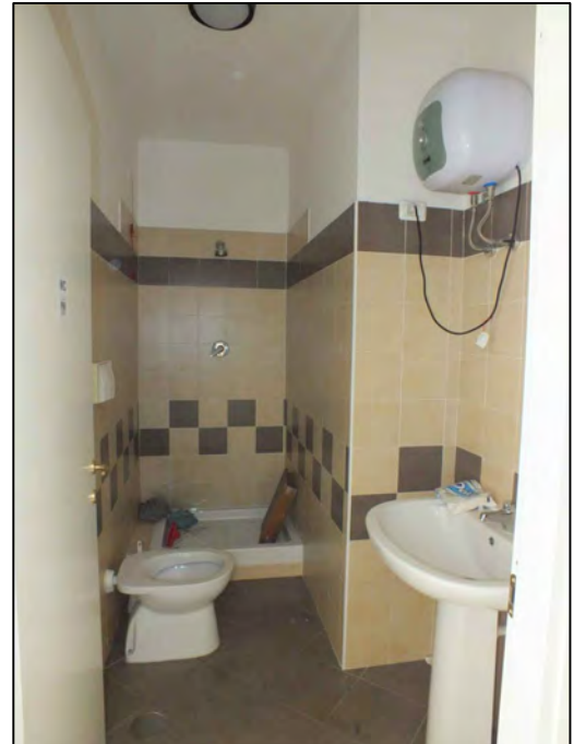
Foto n.ro 18 Bagno
