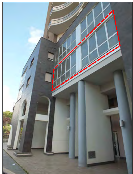
Foto n.ro 4 Prospetto Nord-Est
