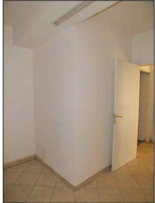
Foto n.ro 18 Ripostiglio
