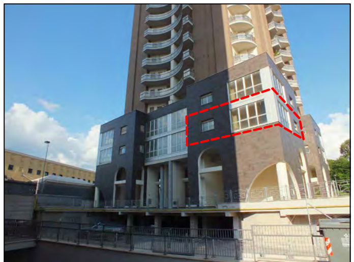
Foto n.ro 4 Prospetto Ovest
