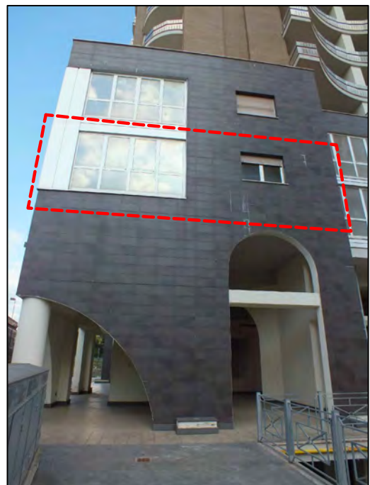
Foto n.ro 4 Prospetto Ovest
