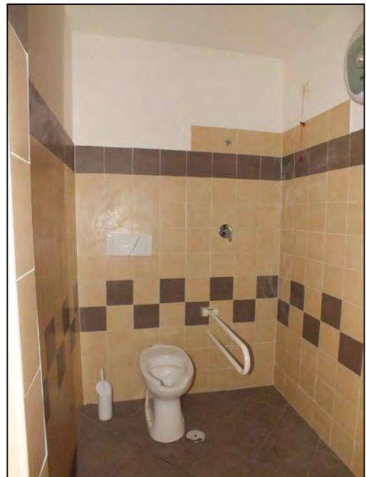
Foto n.ro 20 Bagno
