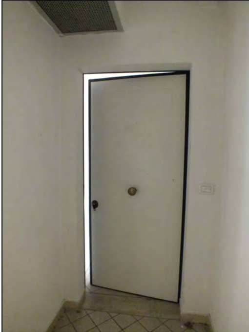
Foto n.ro 5 Ingresso dal disimpegno condominiale
