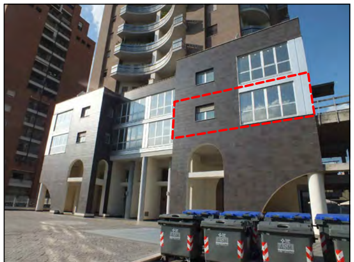
Foto n.ro 4 Prospetto Sud
