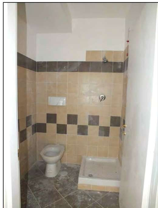
Foto n.ro 16 Bagno
