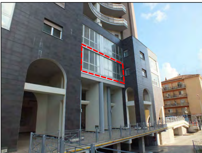
Foto n.ro 3 Prospetto Ovest
