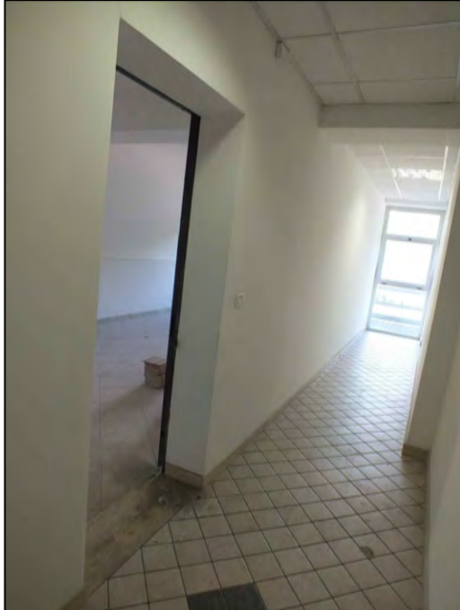
Foto n.ro 5 Ingresso dal disimpegno condominiale
