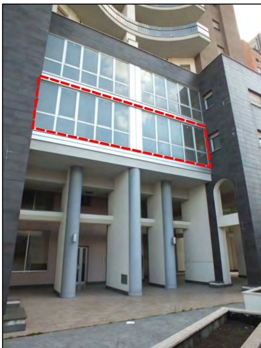
Foto n.ro 3 Prospetto Nord-Est
