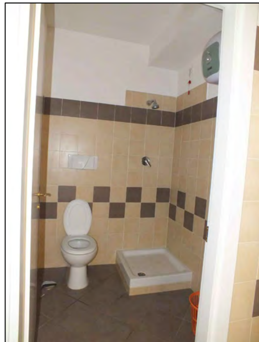
Foto n.ro 16 Bagno
