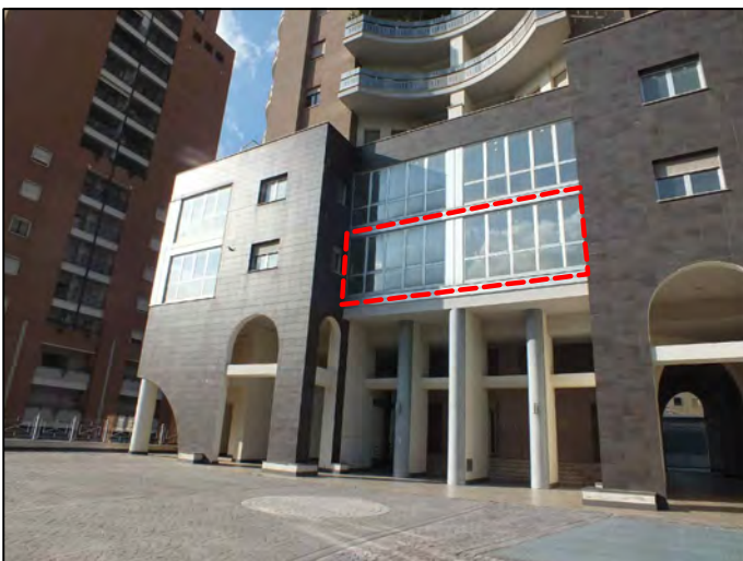
Foto n.ro 3 Prospetto Sud
