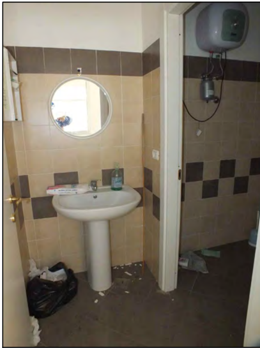
Foto n.ro 21 Anti bagno
