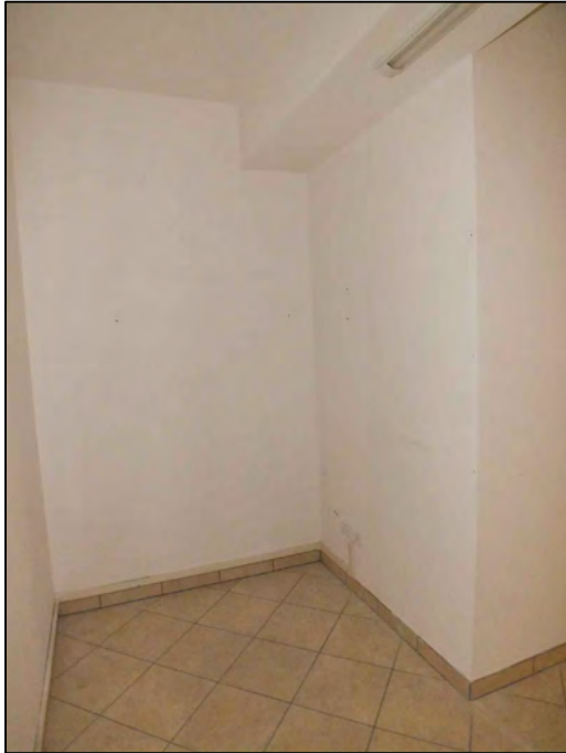
Foto n.ro 17 Ripostiglio
