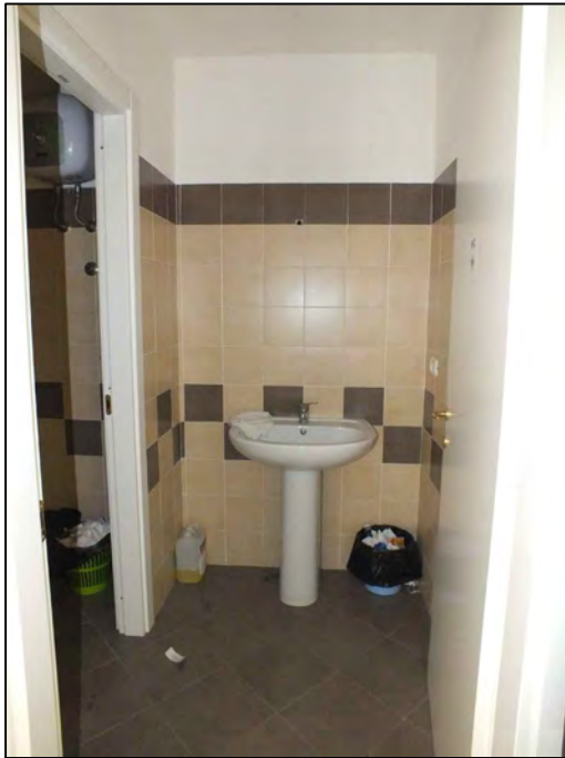
Foto n.ro 17 Anti Bagno
